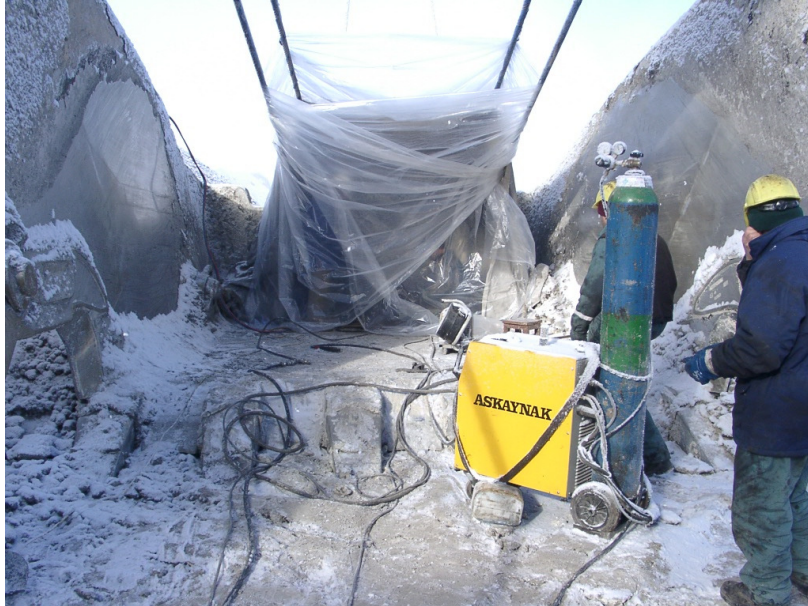
Şekil 3.1 Bakım onarım kapsamında -32 derecede yapılan kaynak işi
