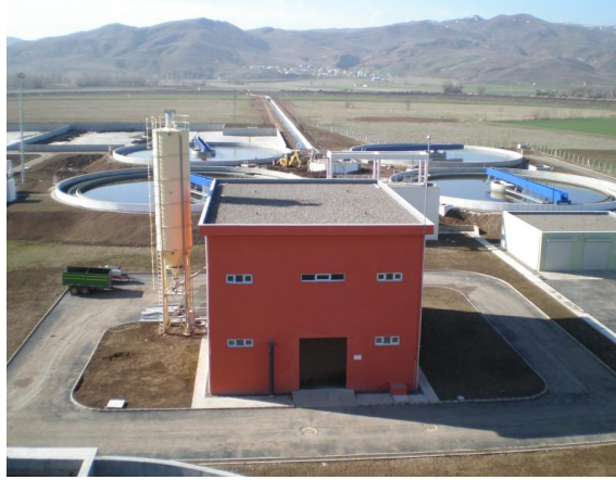
Şekil 5.11 Çamur susuzlaştırma binası
