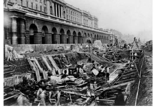
Şekil 2.10 Londra Metrosu'nda aç-kapa yöntemi uygulaması
