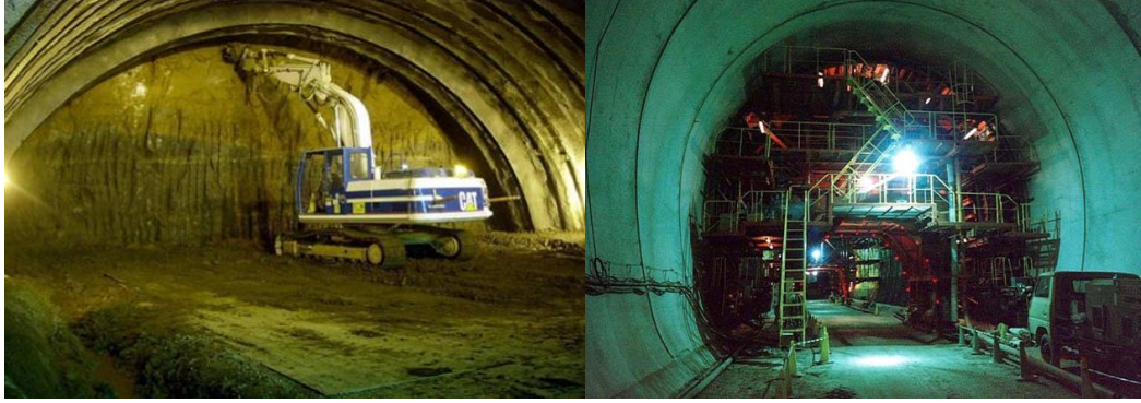
Şekil 2.26 NATM ile inşa edilen tünelden görünümler
