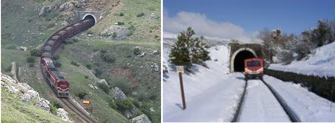
Şekil 2.20 Türkiye demiryollarına ait tünellerden görünüm
