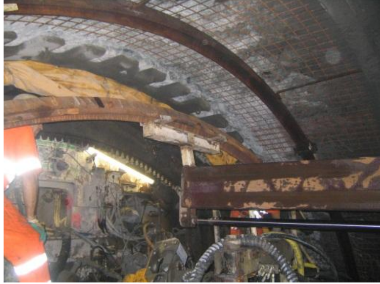
Şekil 2.19 San Gottardo tüneli
