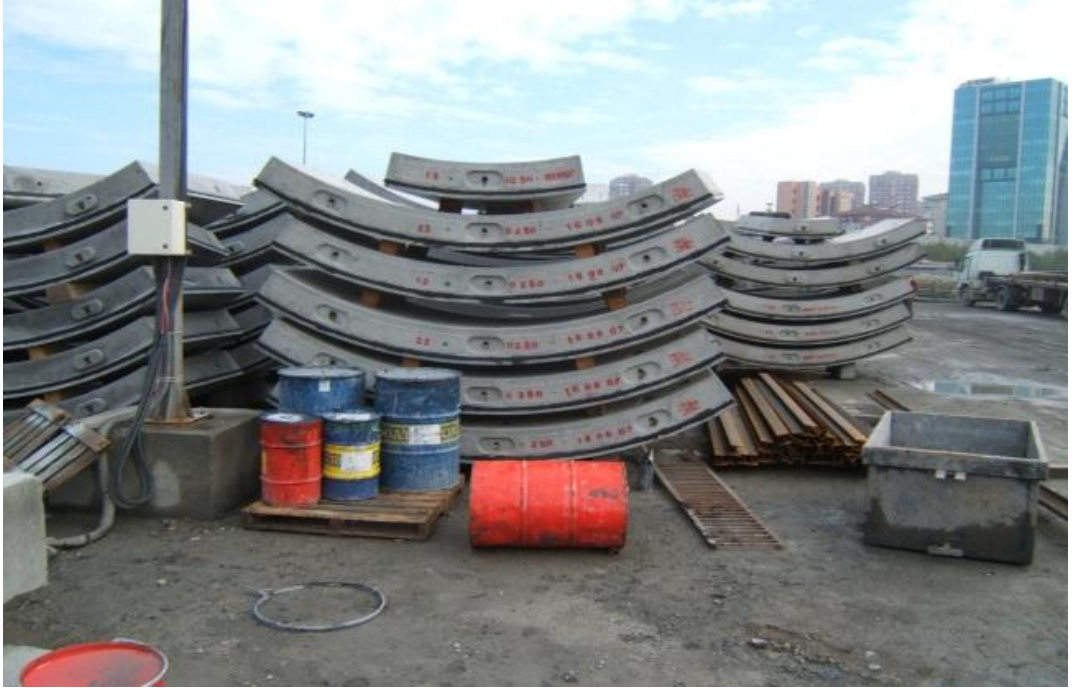
Şekil 2.74 Ön üretimli (Segment) beton elemanlar ve montaj aşamaları
