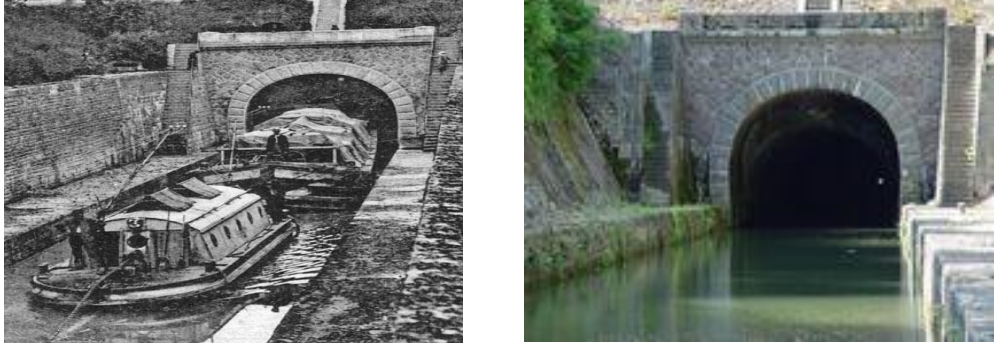
Şekil 2.5 Bourgogne kanalındaki Poulli tüneline görünüm
