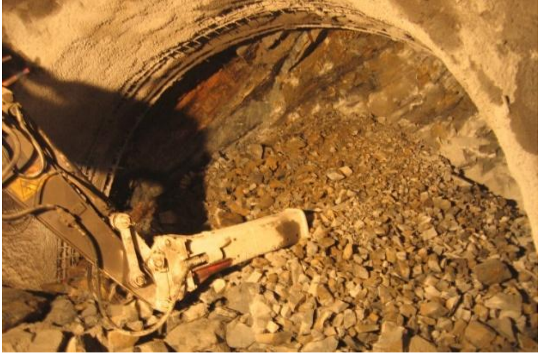
Şekil 2.52 1.adım: Tünel kazısının yapılması
