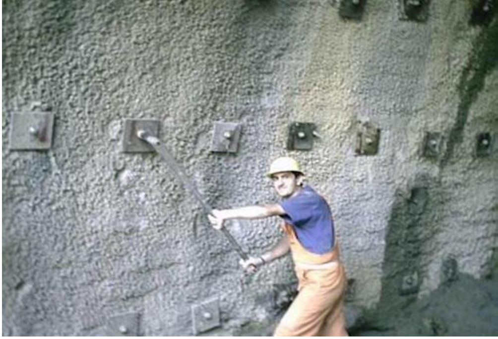
Şekil 2.57 6.adım: bulonlarının yerleştirilmesi ile kazı destekleme işleminin sonlanması
