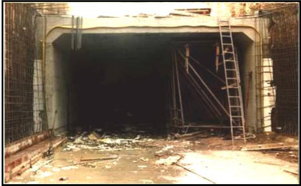
Şekil 2.81 Aç-kapa yöntemi ile inşa edilen tünel
