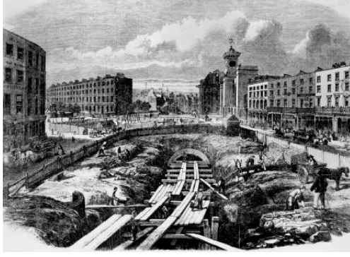
Şekil 2.10 Londra Metrosu'nda aç-kapa yöntemi uygulaması
