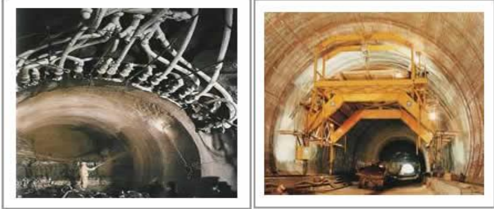
Şekil 2.27 Frankfurt Metrosu, NATM ile yapım aşamalarından görünüm
