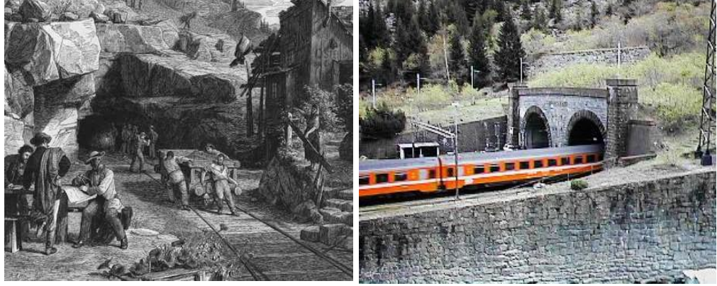
Şekil 2.12 Saint-Gothard çift hat demiryolu tüneline görünüm
