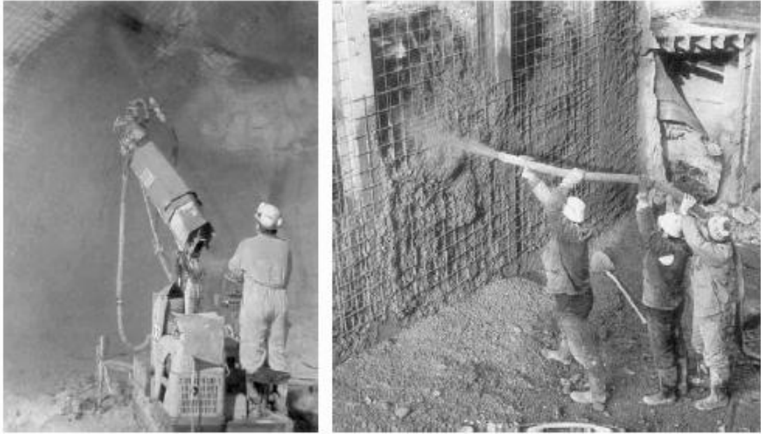
Şekil 2.48 Yaş karışım püskürtme beton uygulaması (Kolymbas, 2005)
