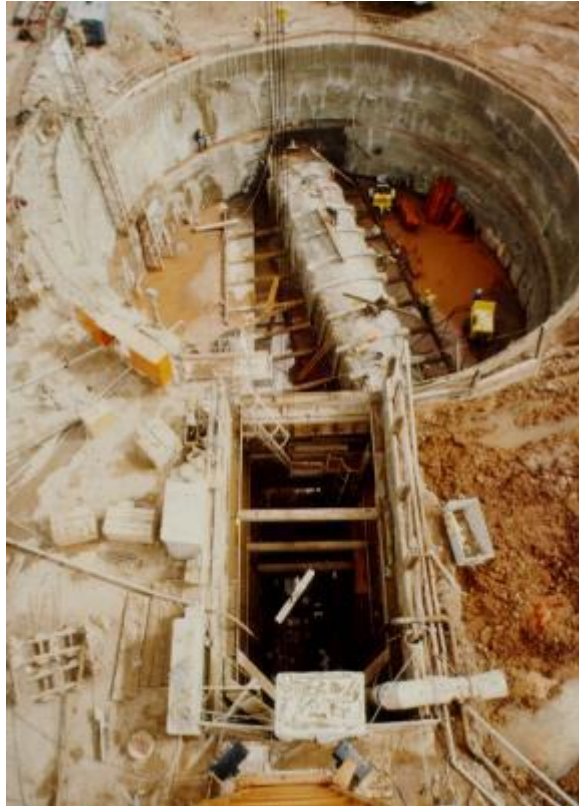
Şekil 2.39 Yeni Avusturya Tünel İnşa Yöntemiyle Açılmış Şaft Birmingham, İngiltere
