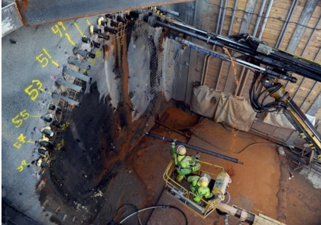
Şekil 2.30 Tynols Corner tüneli şemsiye borusu uygulamasından görünüm
