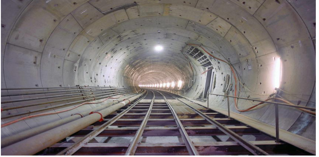
Şekil 2.79 İmalatları tamamlanan tünelden bir görünüm.
