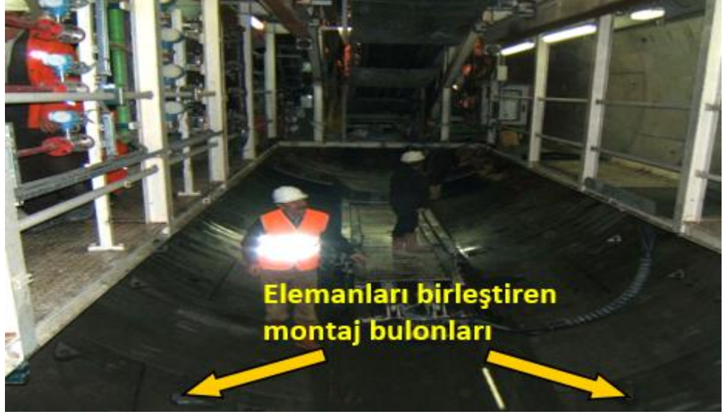
Şekil 2.77 Ön üretilmiş (Segment) beton elemanlar ve montaj aşamaları
