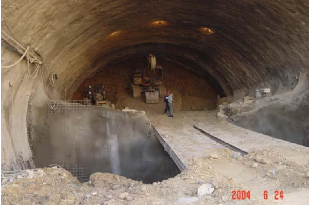
Şekil 2.47 Kademeli Kazı Örneği, Bouira Tüneli
