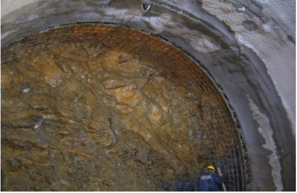
Şekil 2.53 2.adım: Kazı işlemini takiben 1.kat çelik hasırın yerleştirilmesi
