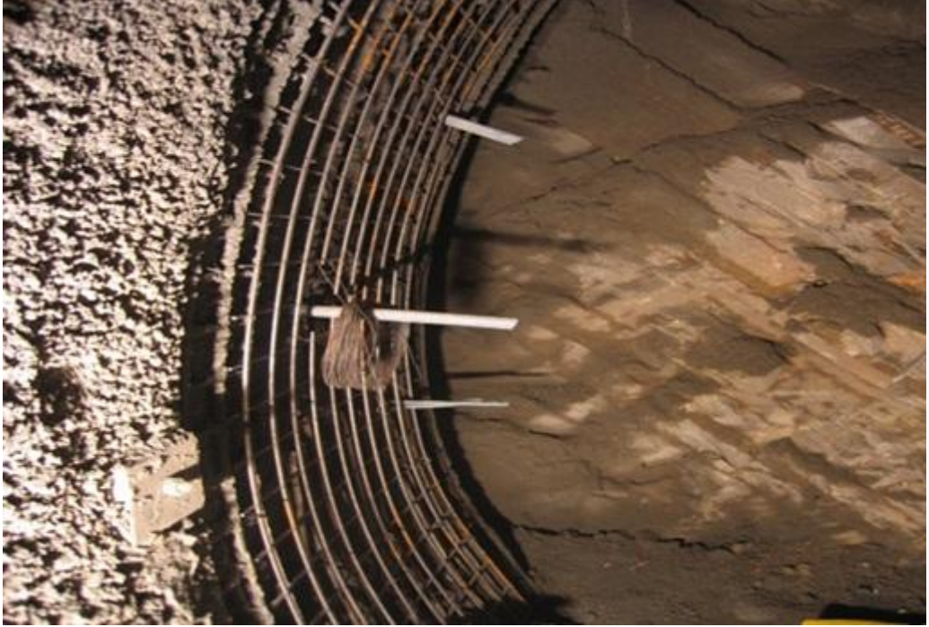
Şekil 2.56 5.adım: İlk kat püskürtme betondan sonra ikinci kat hasır çeliğin yerleştirilmesi
