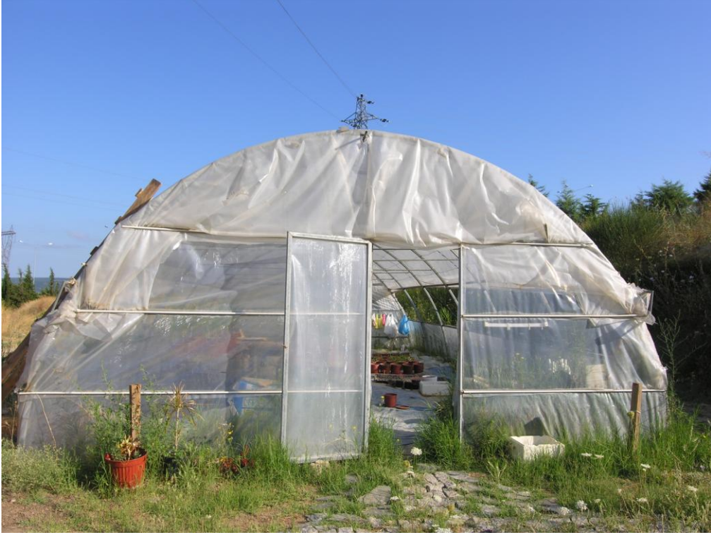
Şekil 21. Sera ön cepheden görünüm.
