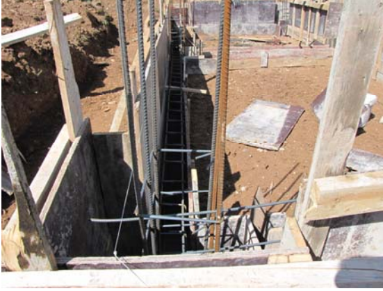
Kolon ve kiriş kalıpları ve betonlarının atılması
