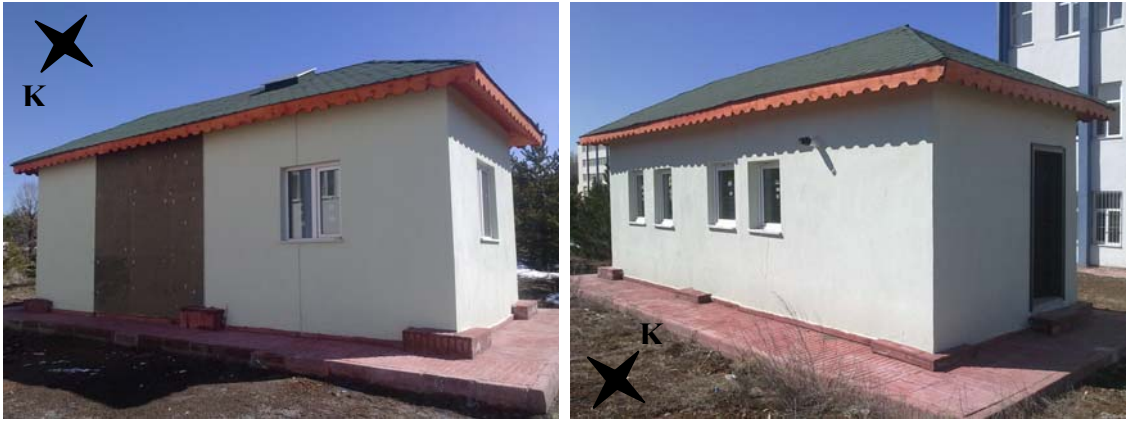
Şekil 4.2 Binanın tamamlanmış hali (Kuzey ve Güney Cephesi)
