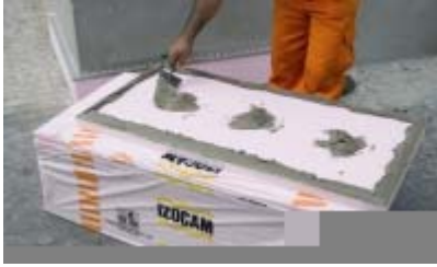
Şekil 2.5 Noktasal yapıştırma metodu
