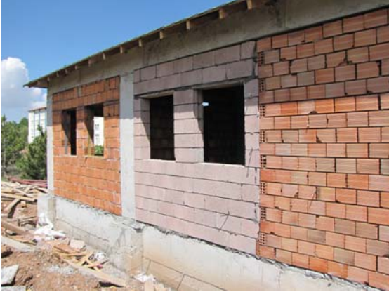
Sandviç duvar ve dıştan yalıtım uygulaması
