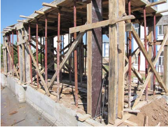
Kolon ve kiriş kalıplarının sökülmesi ve çatının yapımı
