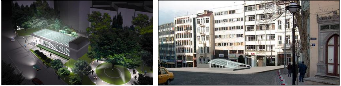
Şekil 5.34: Sirkeci İstasyonu Girişi
