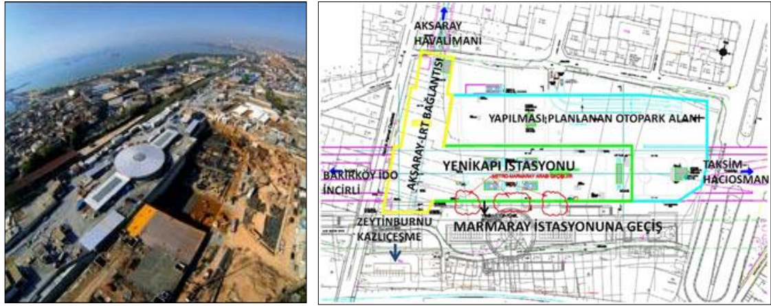
Şekil 5.28: Yenikapı istasyonu transfer merkezi
