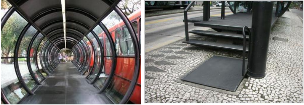
Şekil 4.14: Tüp durak örneği ve durakta engelliler için tasarlanmış asansör
