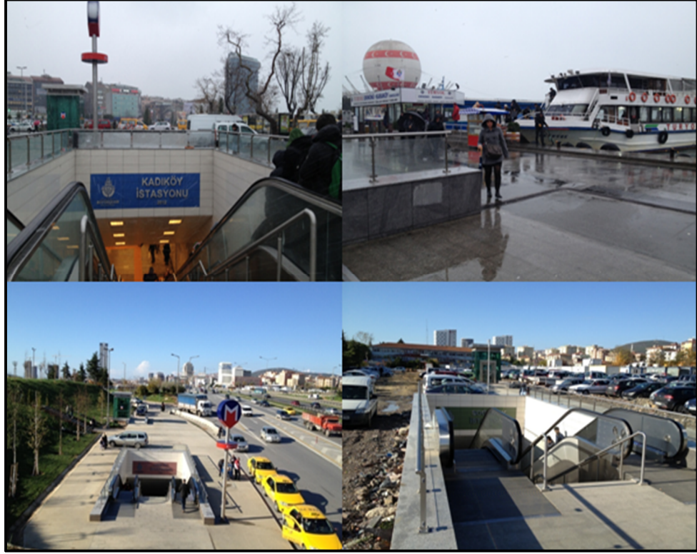
Şekil 6.2: KKM istasyon çıkışlarından görünüm
