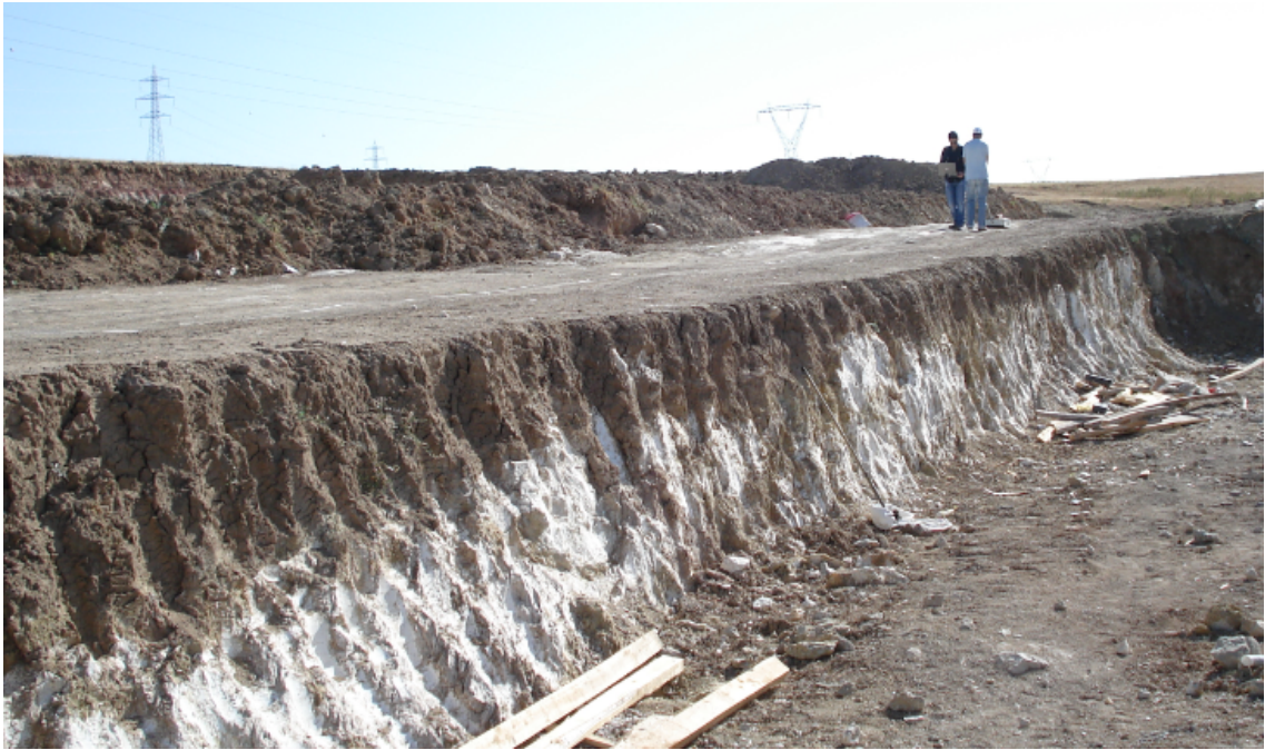
Şekil 3.16 Çalışma Alanında yüzeye yakın jips örneği
