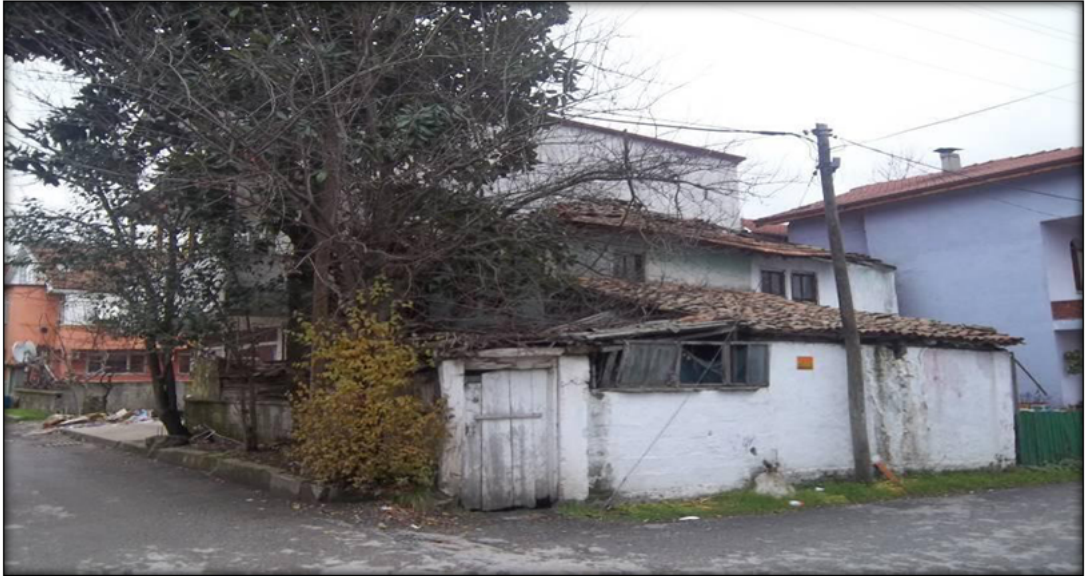
Kaynak: Hendek Belediyesi,2013
