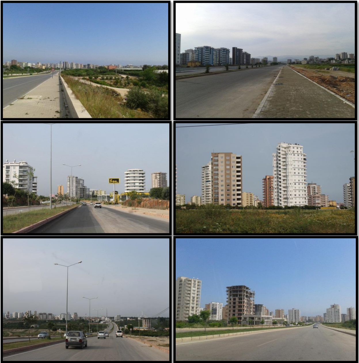
Şekil 4.26: Üniversite Kavşağı Bağlantısında Kentleşme Baskısı
