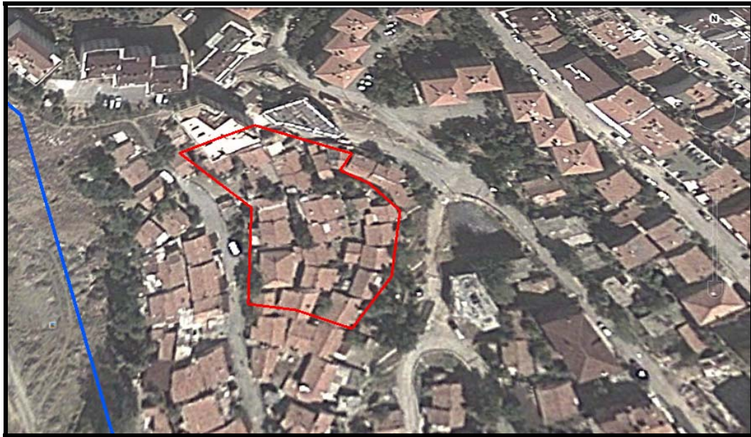
Şekil 4.12: Eyüp İlçesi, Karadolap Mahallesi, 246 Pafta, 743 Ada, 13 Parsel
