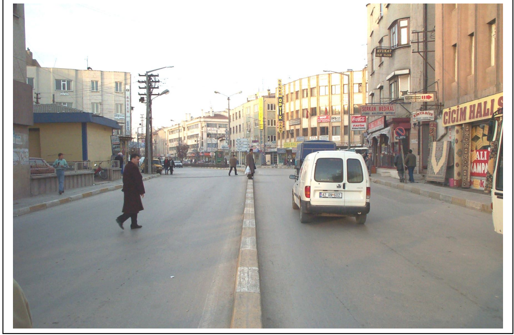
Şekil 4.14. Aziziye caddesi orta refüjünün standart dışı boyutları
