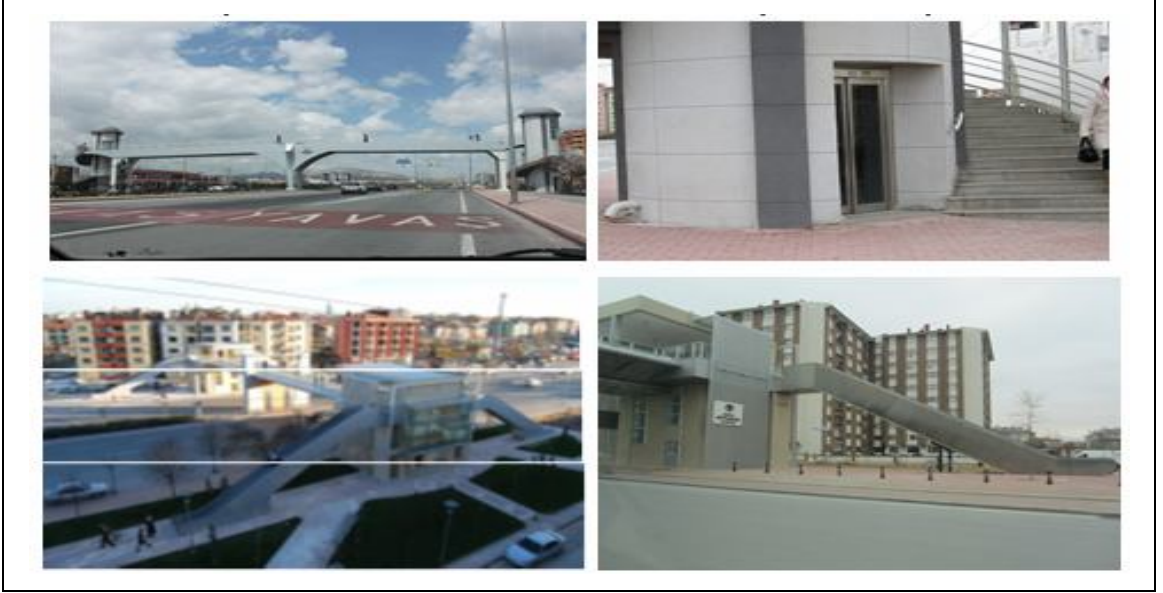
Şekil 3.58. Rampalı ve asansörlü yaya üst geçitleri: yürüyen merdiven ve asansör bir arada uygulanmıştır
