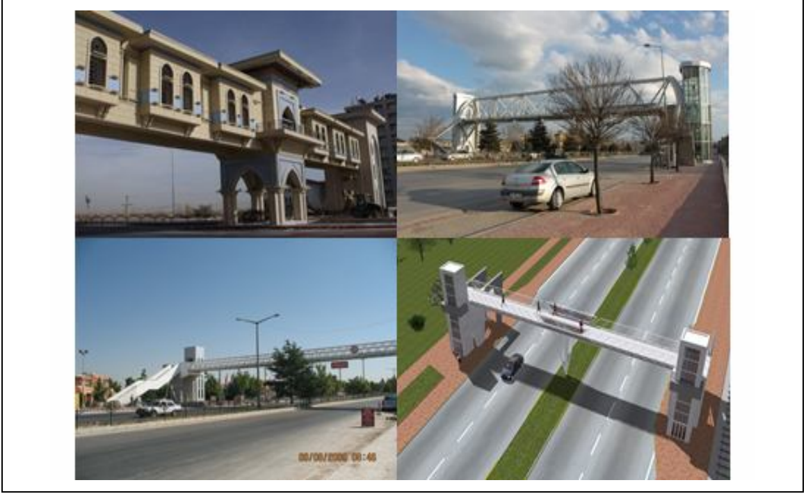
Şekil 3.56. Rampalı ve asansörlü yaya üst geçitleri
