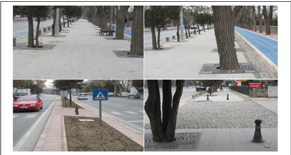
Şekil 3.62. Erişebilirlik kriterlerine uygun tanzim edilen yollar: kod farklarının giderilmesi
