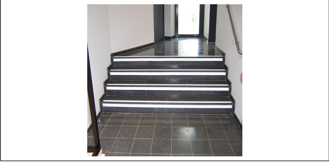
Şekil 3.50. Mevlana kültür merkezi erişebilirlik düzenlemeleri: merdiven uygulamaları
