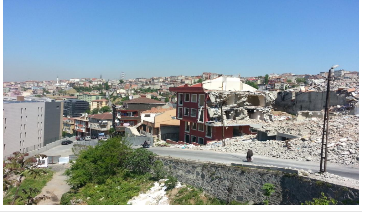
Şekil 4.10: Proje alanındaki mevcut durumu-1
