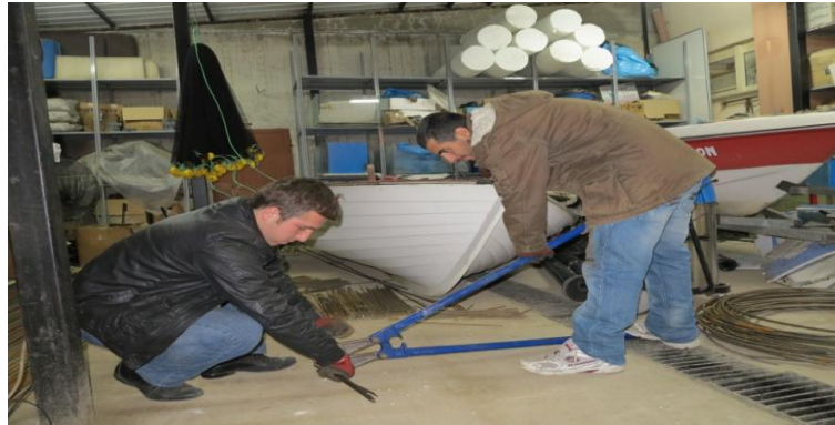
Şekil 3.5. Sepet demirlerinin kesilmesi işlemi
