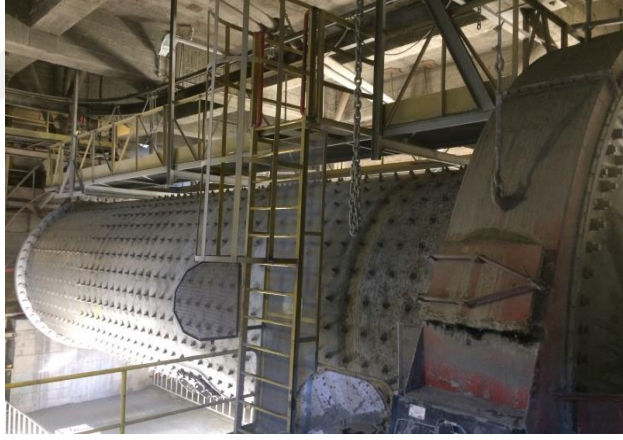
Şekil 3.14 Çimento değirmeni giriş bölümü genel görünümü.
