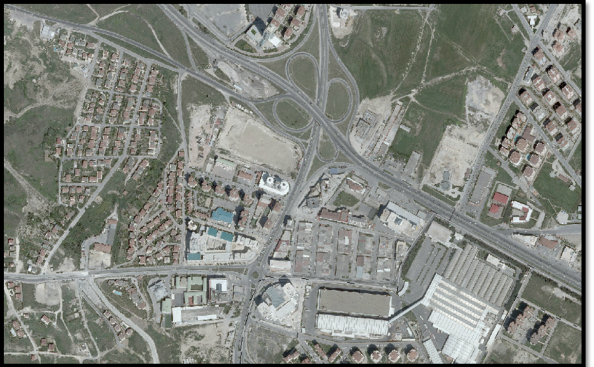
Şekil 5.4 Beykent İstasyonu Çevresindeki Mevcut Yapılaşma
