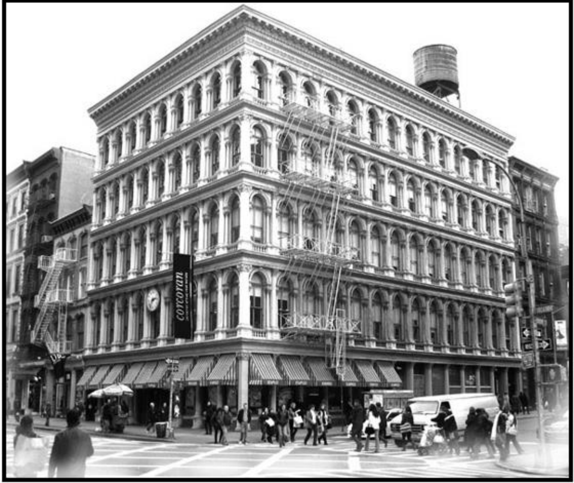
Şekil 2.9: Haughwout Binası, Soho
