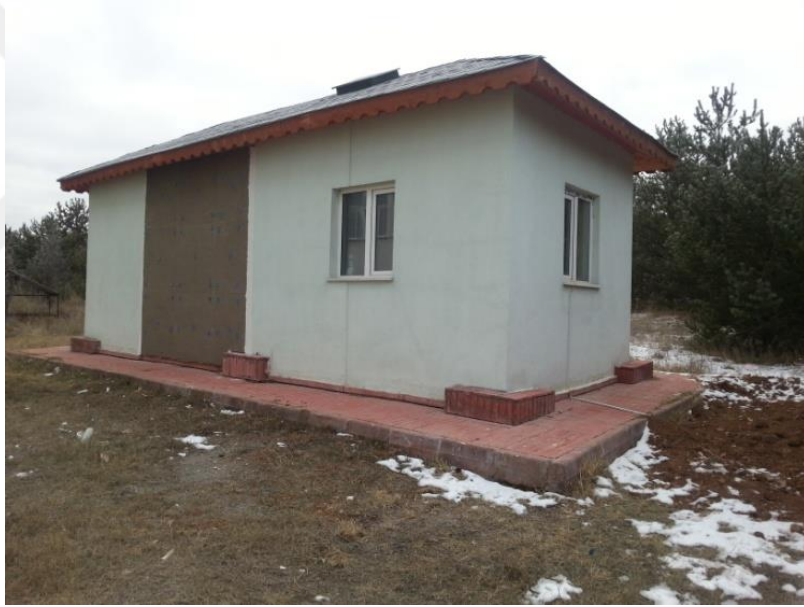
Şekil 3.1 Enerji evinin kuzey cepheden görünüşü
