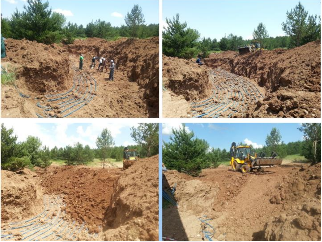
Şekil 3.5 Toprak ısı deęiřtircilerinin yerleřtirilme ařamaları
