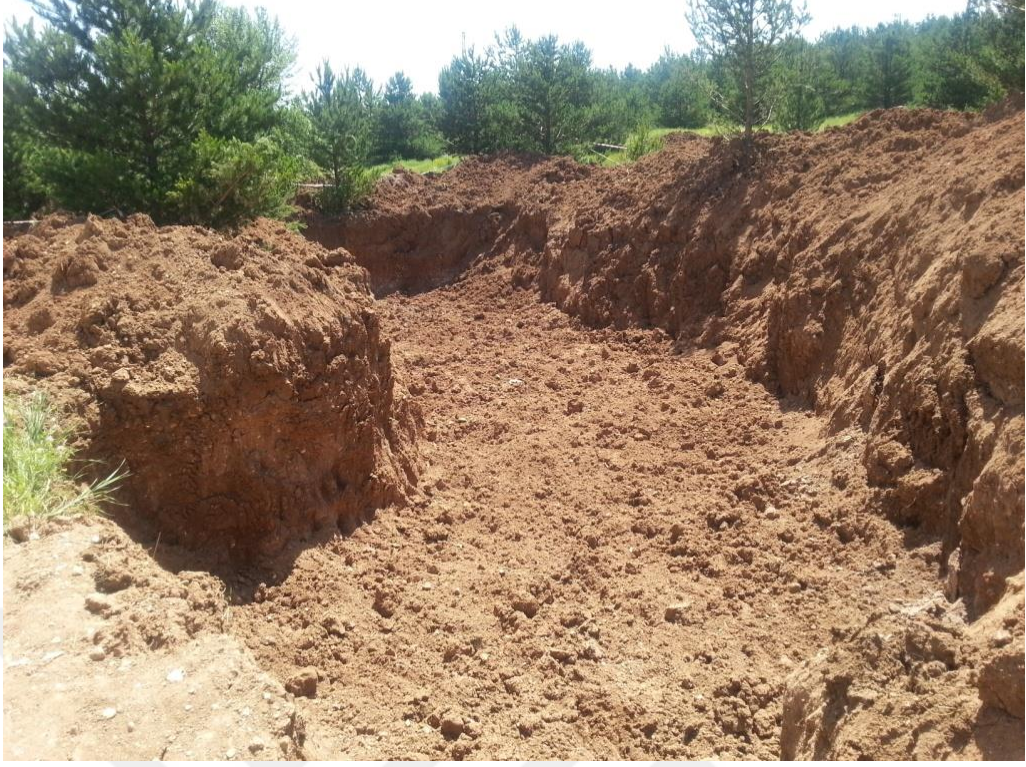
Şekil 3.4 Kazı işleminin sonunda kazı alanı
