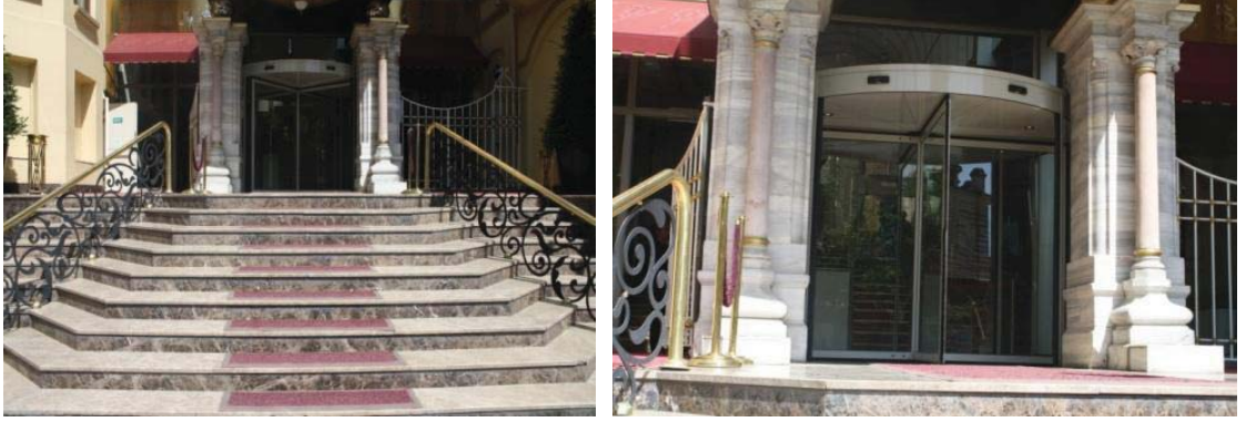
Şekil 4.7 Crown Plaza Hotel giriş kapısı
