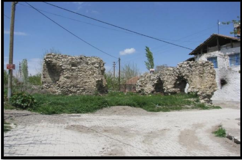
Şekil 4.11: Eski Malatya, güney iç sur ve kalıntısı
