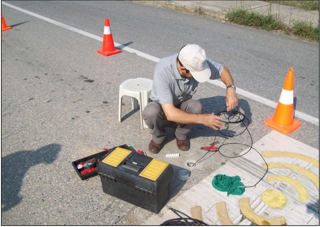
Şekil 4.12: Manyetik sensörün asfaltın altına yerleştirilmesi
