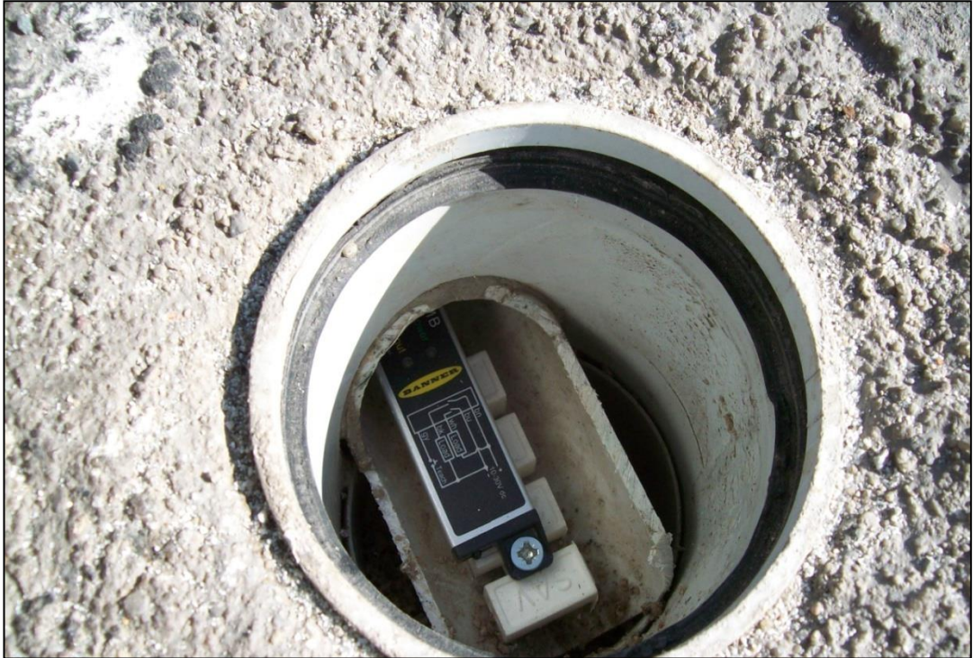
Şekil 4.13: Manyetik sensörün asfaltın altına yerleştirilmesi
