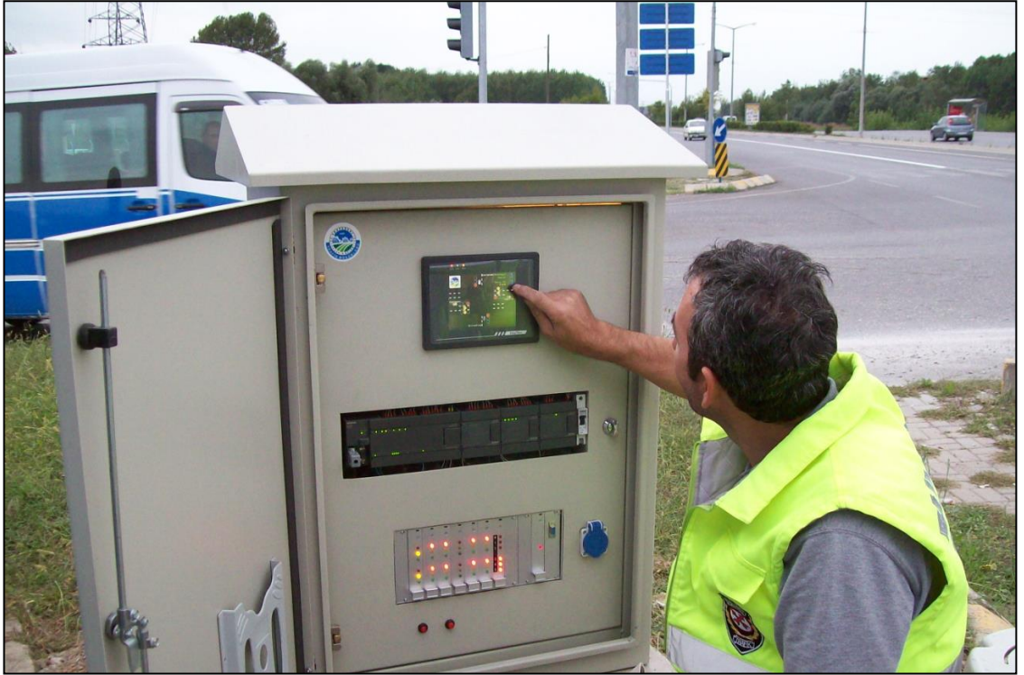
Şekil 4.6: Geliştirilmiş KKC montajı yapılmış hali
