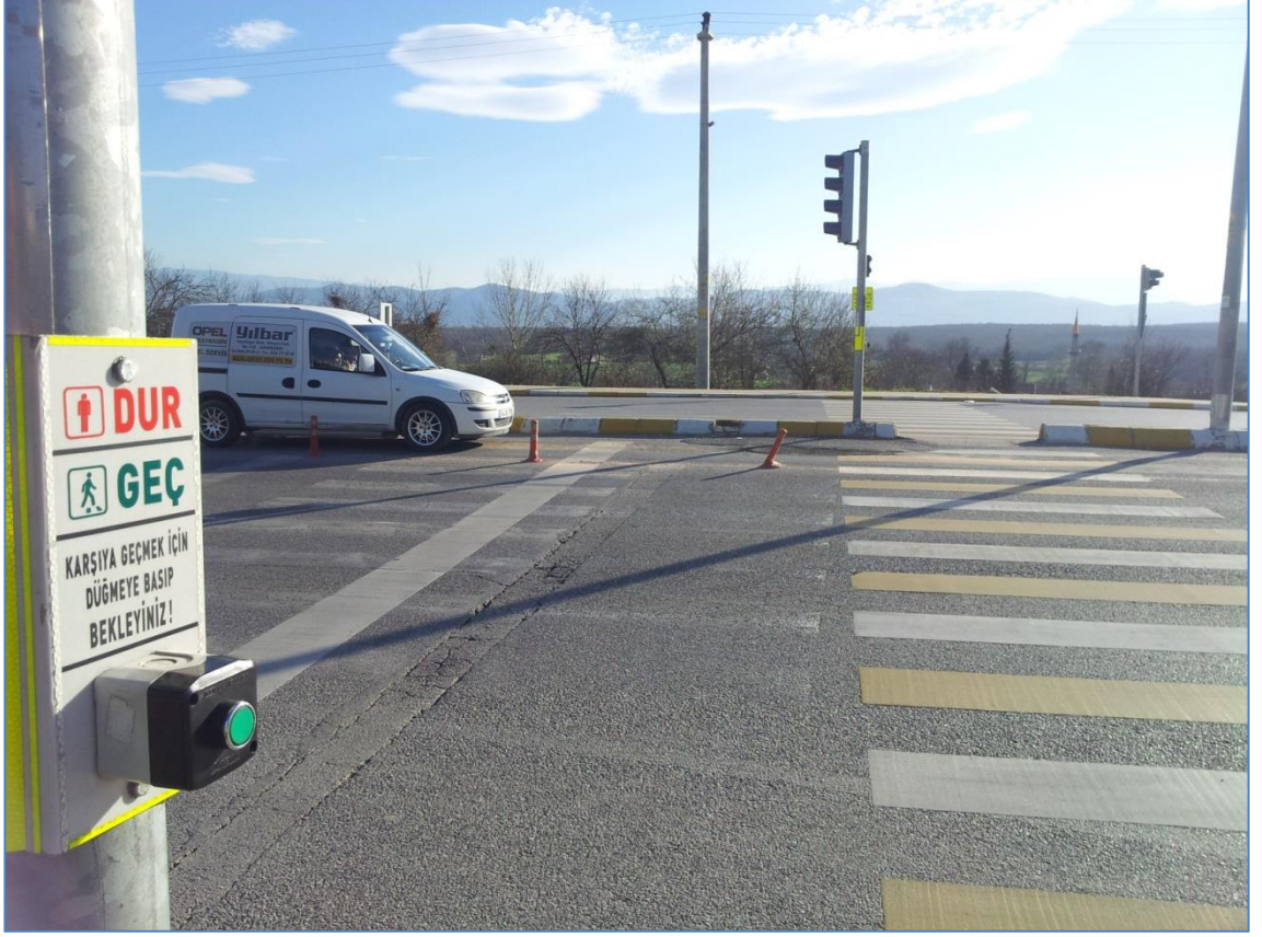
Şekil 4.17: Yaya butonlarının sahaya uygulanması
