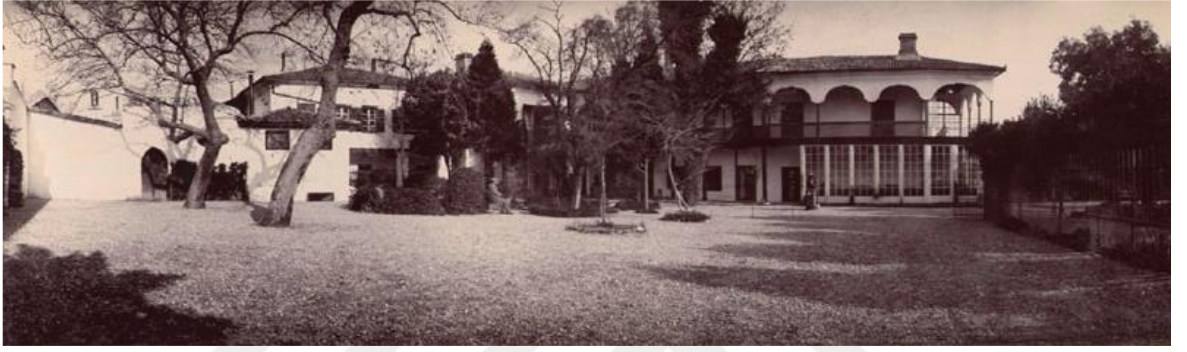
Şekil 2.2. Söke'de bulunan Forbes Köşkü (Uygun, 2015)
