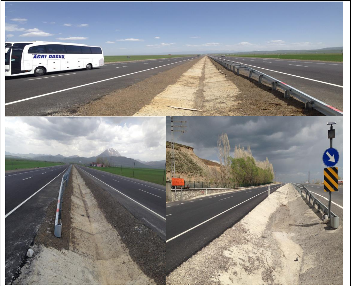
Şekil 2.10: Hendeğe paralel yapılan oto korkuluk
