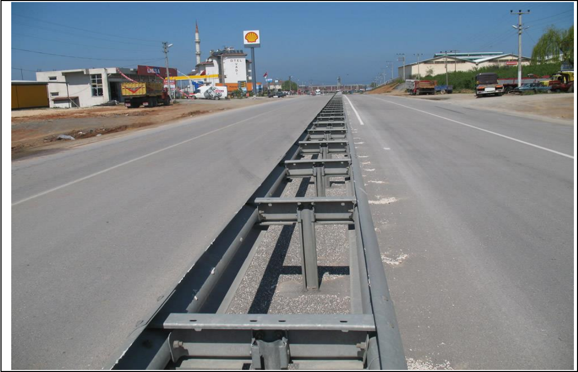
Şekil 1.21: Çift taraflı mesafeli otokorkuluk (2,00 m dikme aralıklı)
