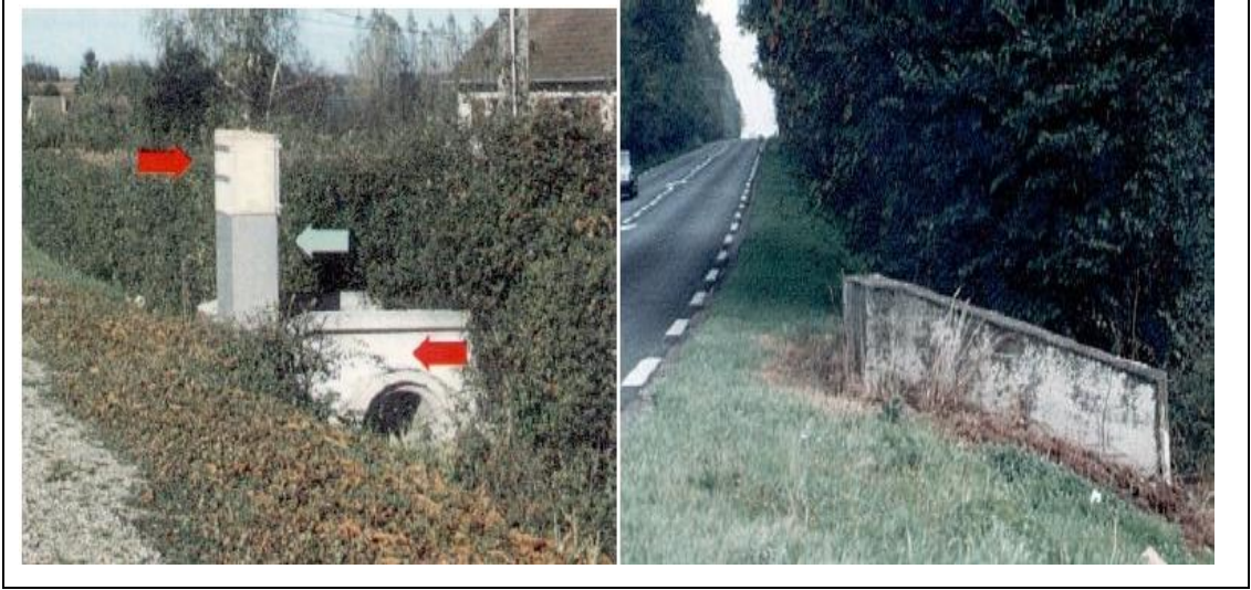
Şekil 1.14: Drenaj boru örneği ve menfez duvarı
