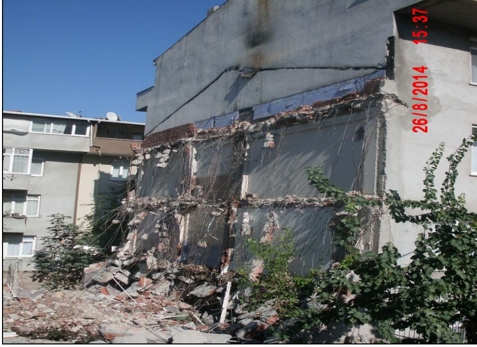
Şekil 4.23: GÖB ikiz nizam yapı fotoğrafı-1
