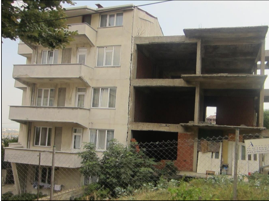
Şekil 4.24: GÖB ikiz nizam yapı fotoğrafı-2
