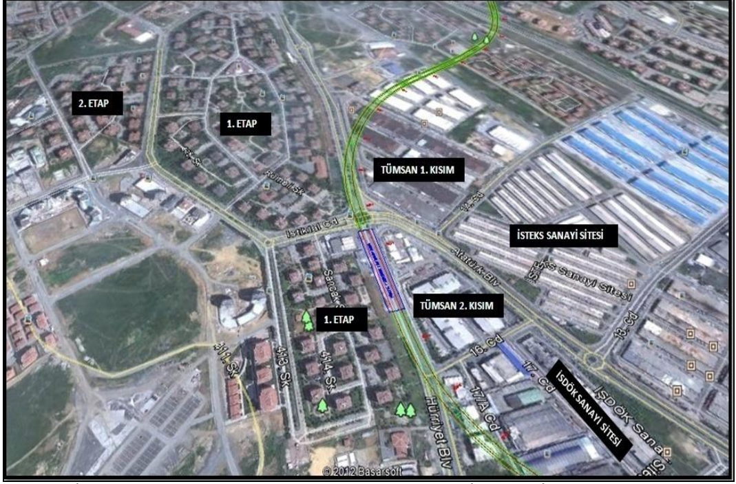
Şekil 6.12: M3 Metro hattı Başak Konutları İstasyonunun havadan çevre görüntüsü
