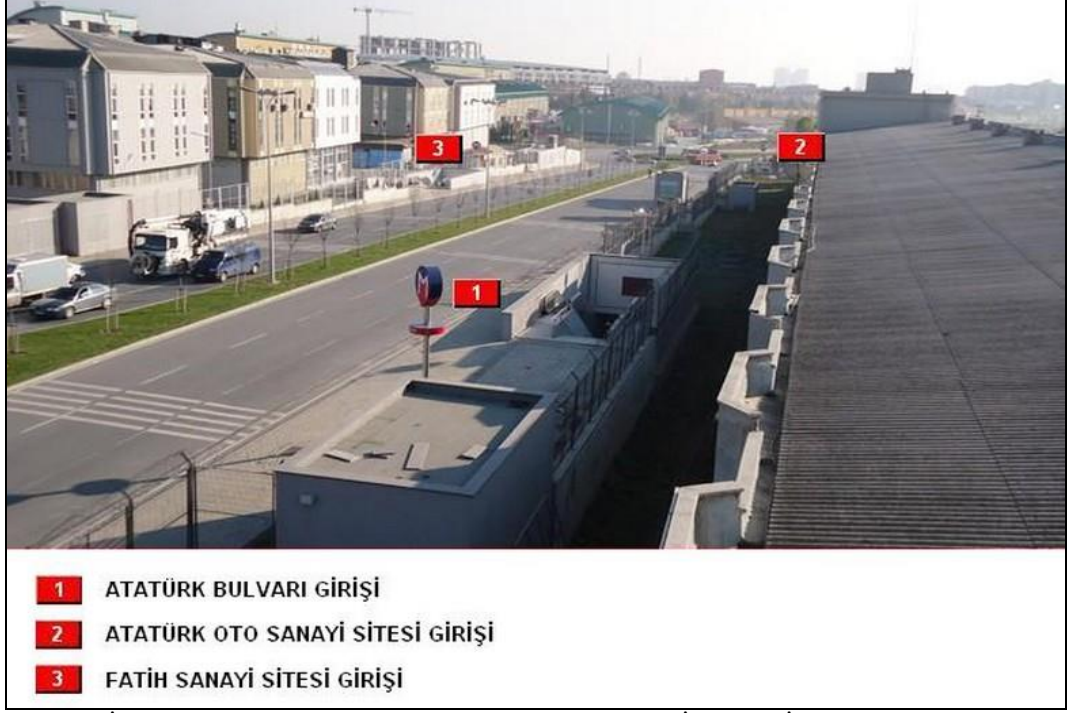
Şekil 6.14: M3 Metro hattı Siteler İstasyonu girişleri
