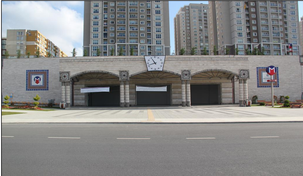
Şekil 6.5: M3 Metro hattı Metrokent İstasyonu girişlerinden biri
