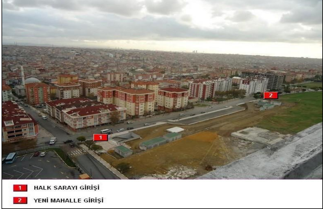
Şekil 6.40: M3 hattı Turgut Özal İstasyonu girişleri
