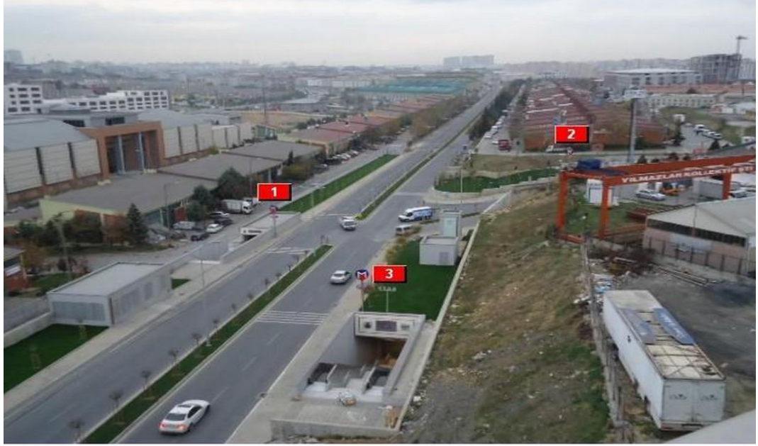
Şekil 6.19: M3 hattı Turgut Özal İstasyonu girişleri
