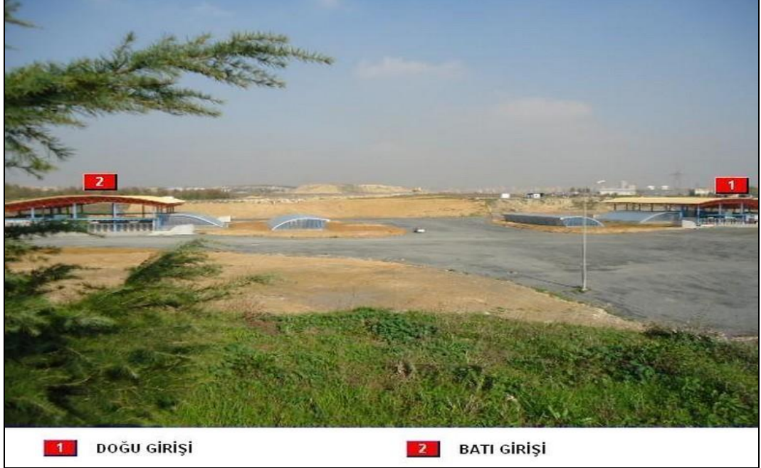
Şekil 6.56: M3 Metro hattı Olimpiyat İstasyonu girişleri
