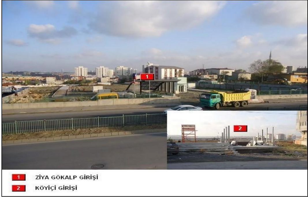
Şekil 6.51: M3 Metro hattı Ziya Gökalp İstasyonu girişleri
