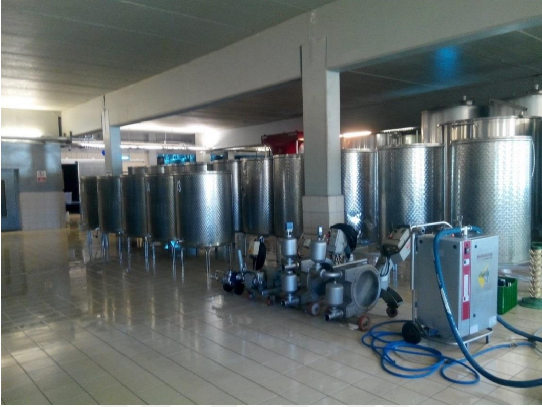
Şekil 4.1. Şaraphane bölümü kaygan zemin
