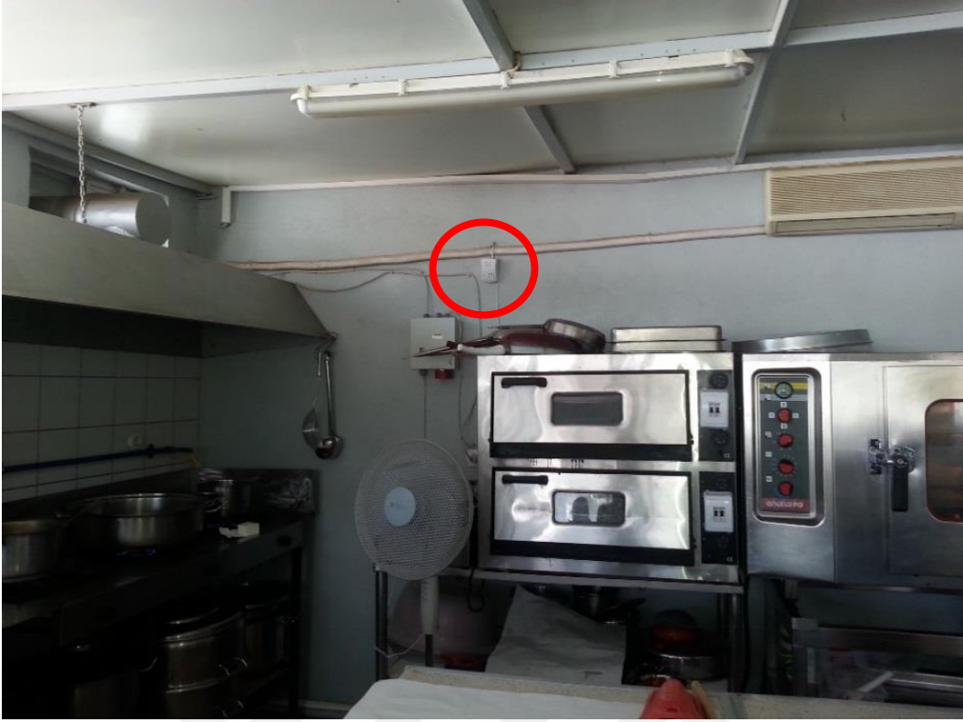
Şekil 5.29. Yemekhane bölümüne takılan gaz dedektörü
