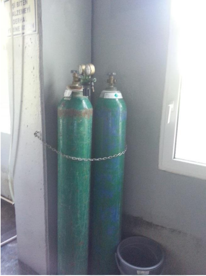
Şekil 5.13. Fabrika içerisinde kullanılan tüplerin zincirlenerek konumlandırılması
