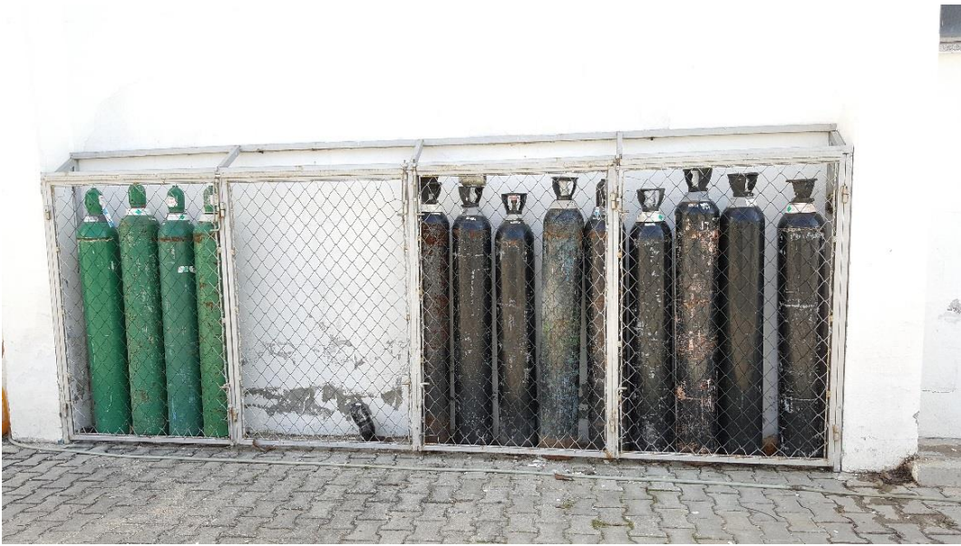
Şekil 5.14. Fabrikadaki tüplerin dik konumda depolanması
