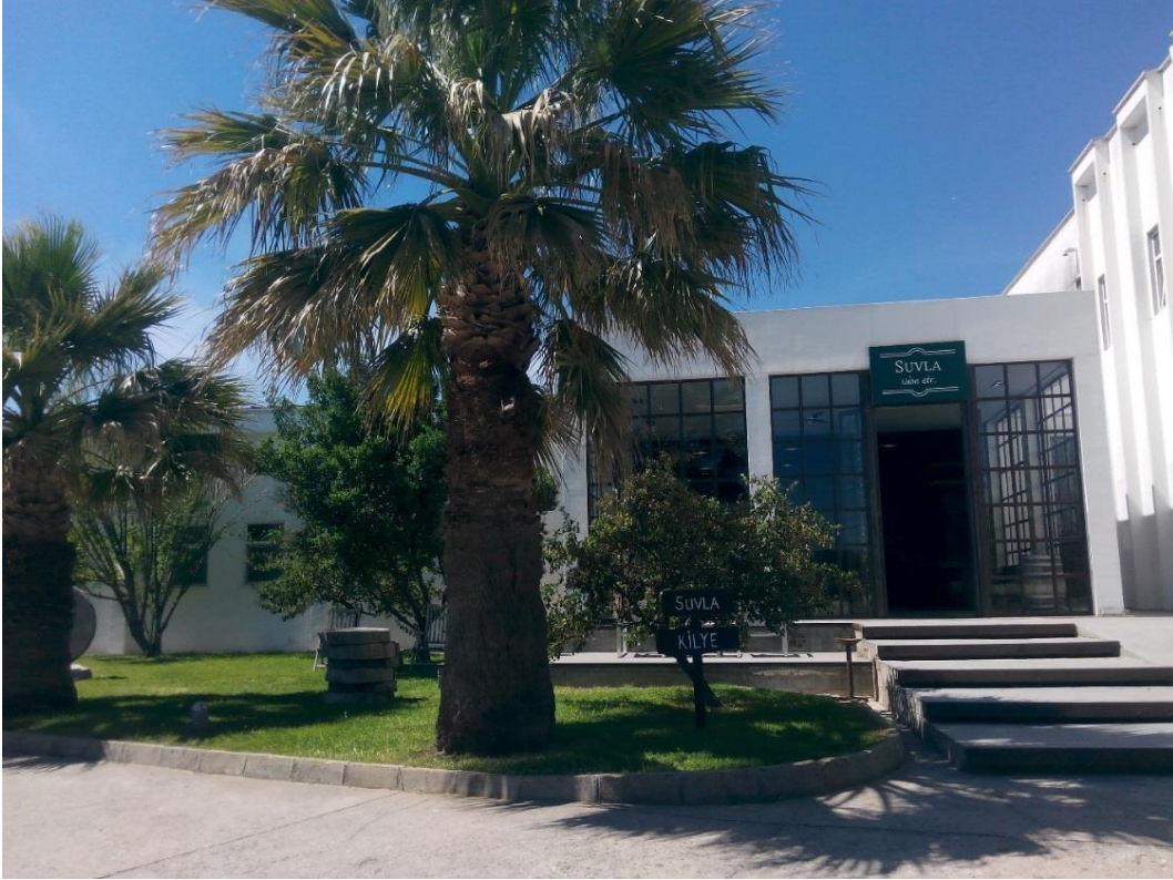
Şekil 3.1. Suvla Şarapları fabrikası
