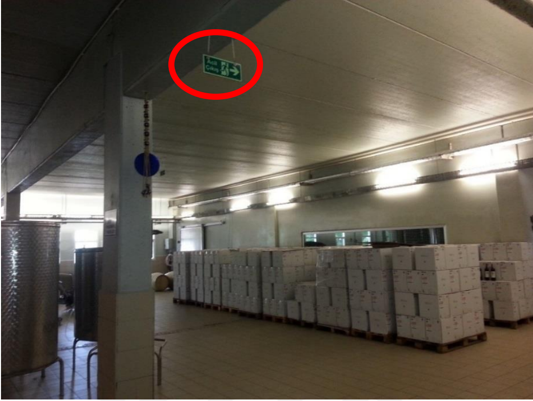
Şekil 5.30. Şaraphane bölümündeki acil çıkış yönlendirme levhası
