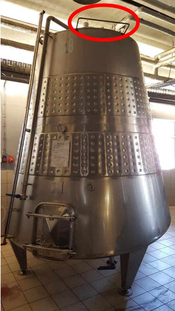
Şekil 5.1. Tankların üzerinde bulunan merdiven asma aparatının uygun takılması
