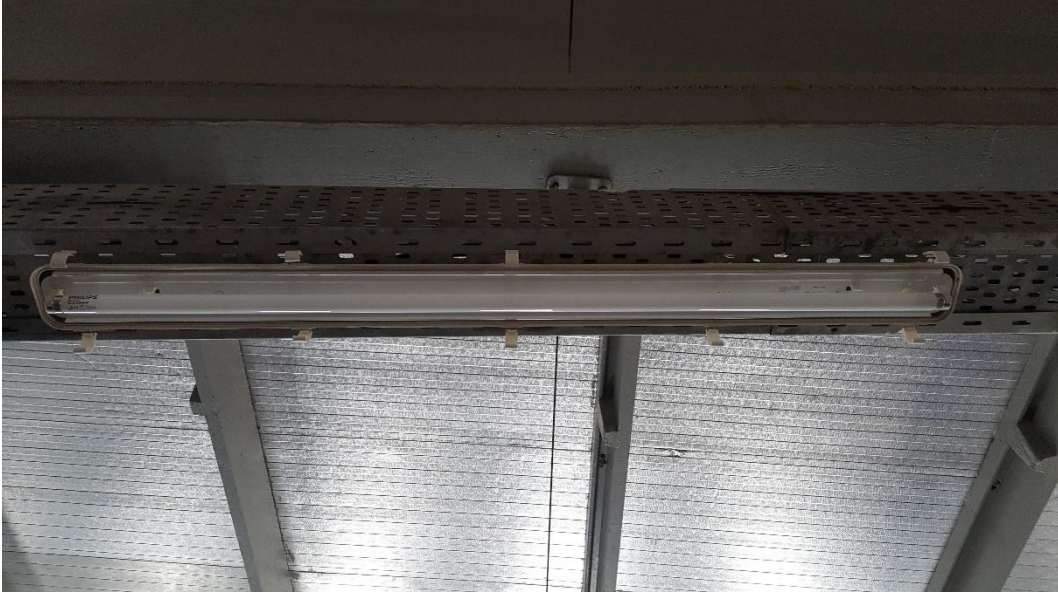
Şekil 4.21. Etanj olmayan lambalar
