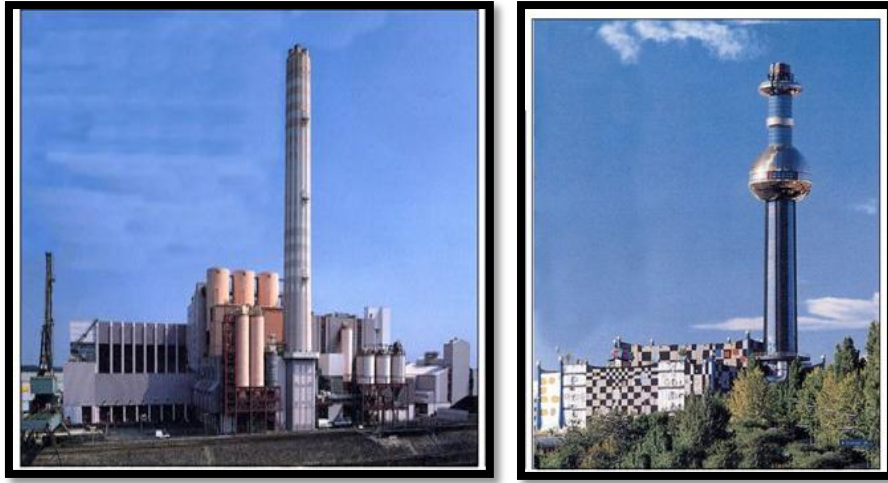
Şekil 2.14: Farklı Yapılardaki Atık Yakma Tesisleri
