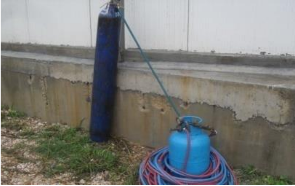
2.b. Oksijen tüpünün devrilmeye karşı sabitlenmesi
