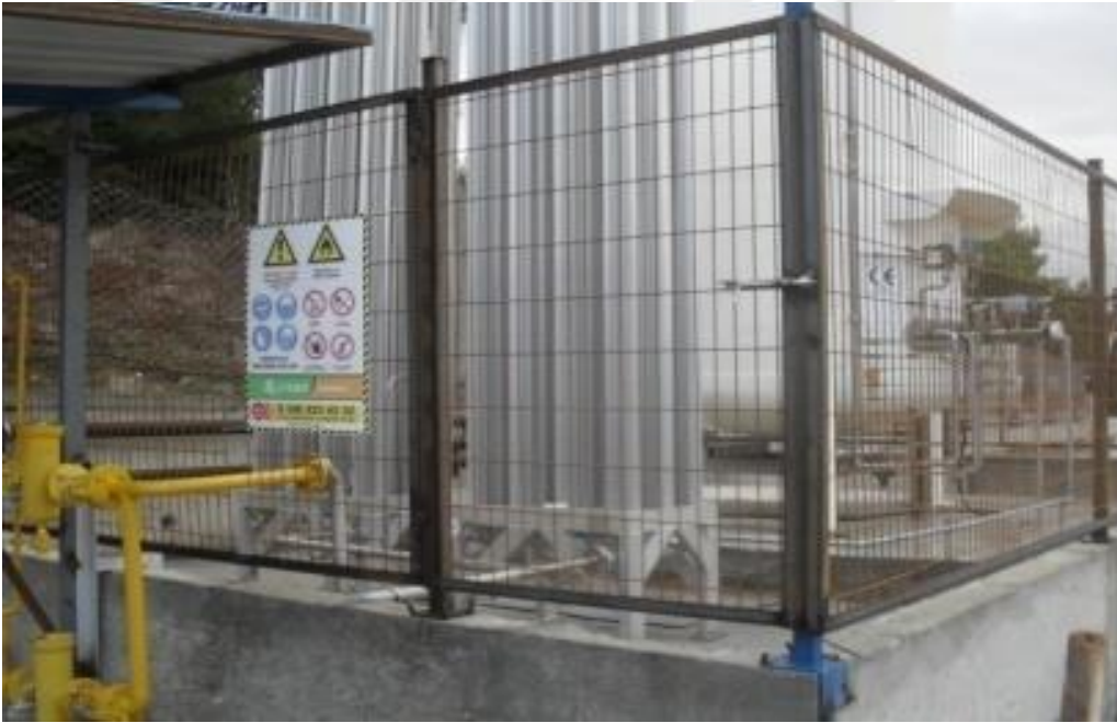
3.b. Gaz tankının etrafının çevrilmesi
