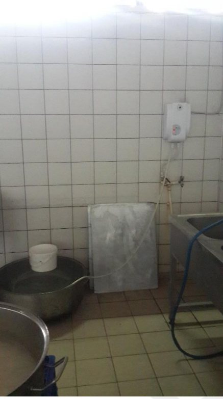
9. Islak zeminler, elektrikli isticinin nemli ortamdan izole edilmemesi, ergonomik olmayan bulaşıkhanane.
