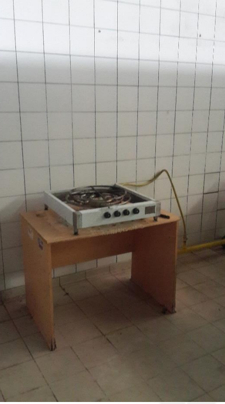
5. Ocak ve bağlantılarının standartları karşılamaması, davlumbaz bulunmaması.
