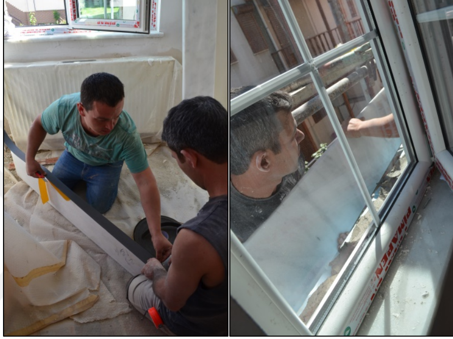
Şekil 3.14: Denizlik mermeri ısı yalıtımı
