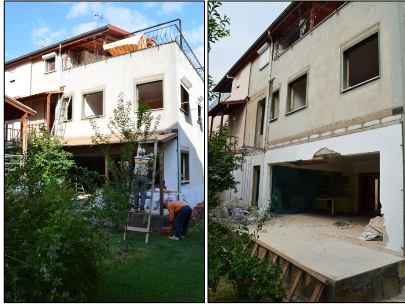
Şekil 3.8: Sundurma çatı yıkımı
