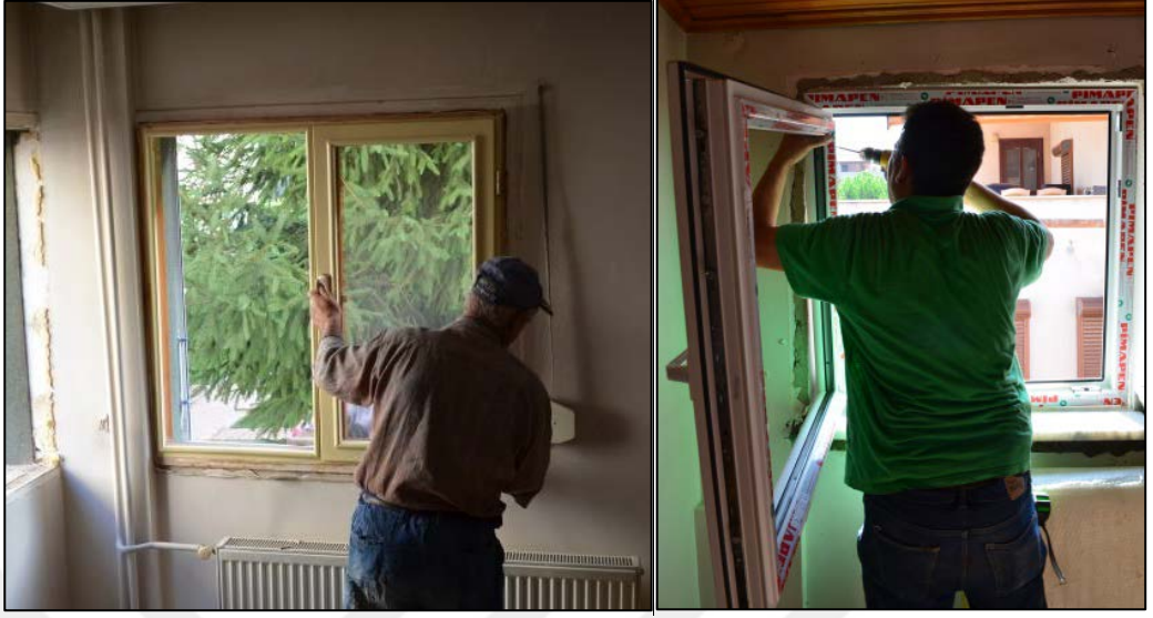
Şekil 3.13: Uygulanan PVC pencere detayı
