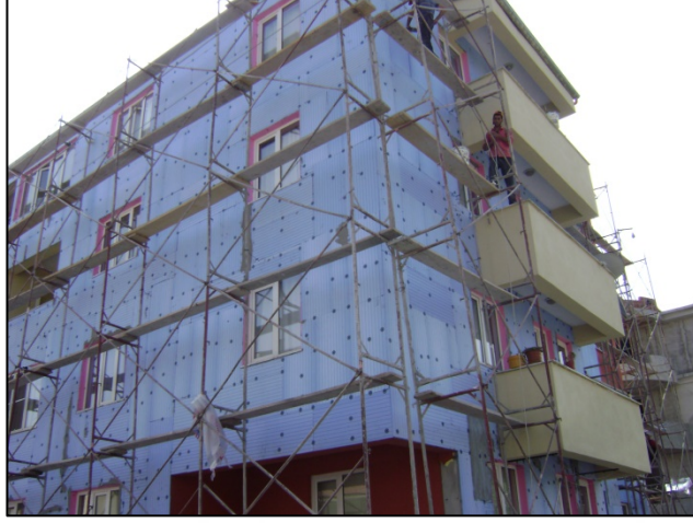
Şekil 2.35: Mevcut yapılarda ısı yalıtımı
