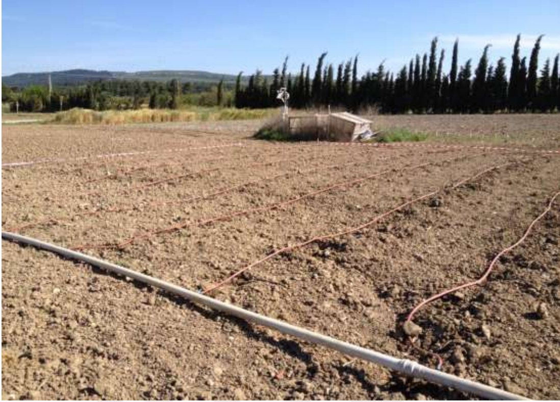
Şekil 3.6. Deneme alanında ana ve lateral damlama borularının kurulumu
