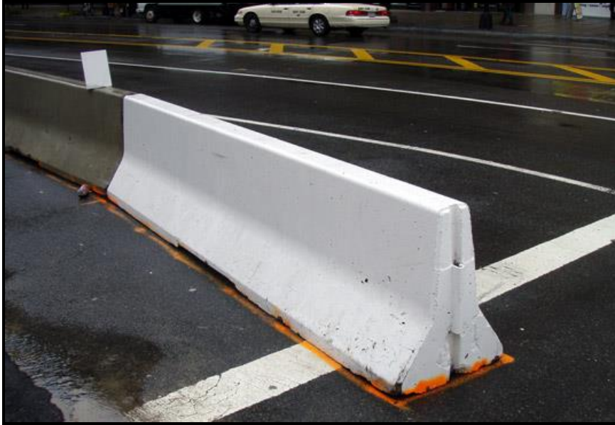
Şekil 4.20: Seyyar beton bariyerler
