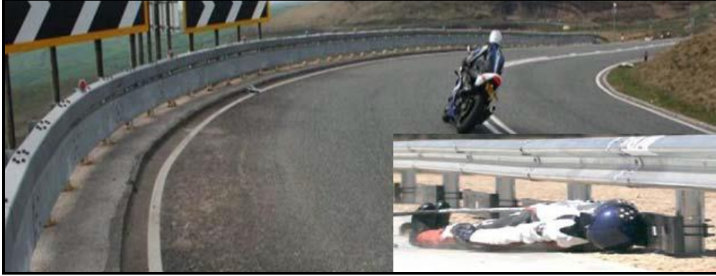
Şekil 7.6: Ağır vasıta ve motosiklet sürücüleri düşünülerek tasarlanmış bariyer sistemleri
