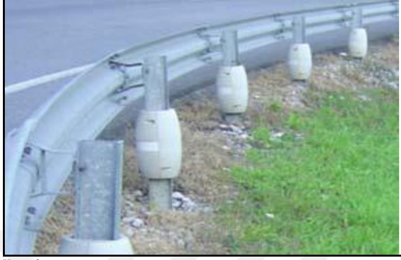
Şekil 7.4: Plastik malzemeden üretilen ve yalnızca dikmelere monte motosiklet koruma sistemi
