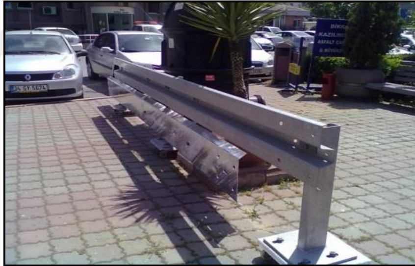
Şekil 8.4: İstanbul Büyükşehir Belediyesi, Yol Bakım ve Altyapı Koordinasyon Daire Başkanlığı tarafından uygulanmak üzere standartlara uygun yaptırılan örnek motosiklet koruma sistemi
