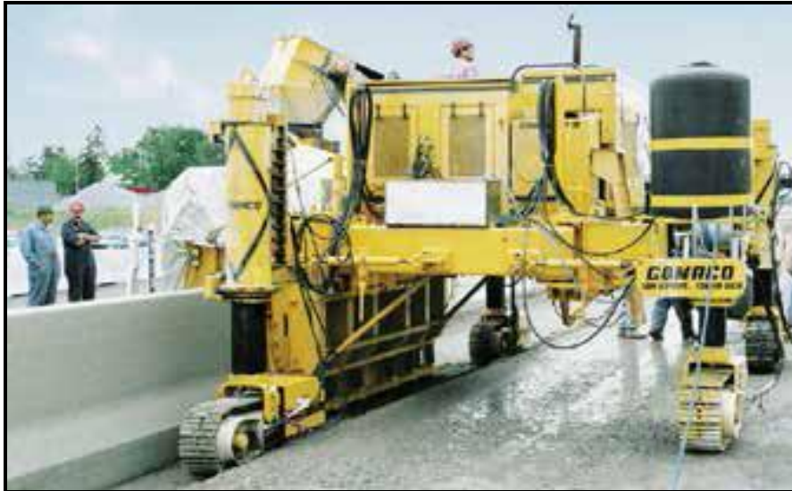
Şekil 4.16: Yerinde döküm beton bariyerler
