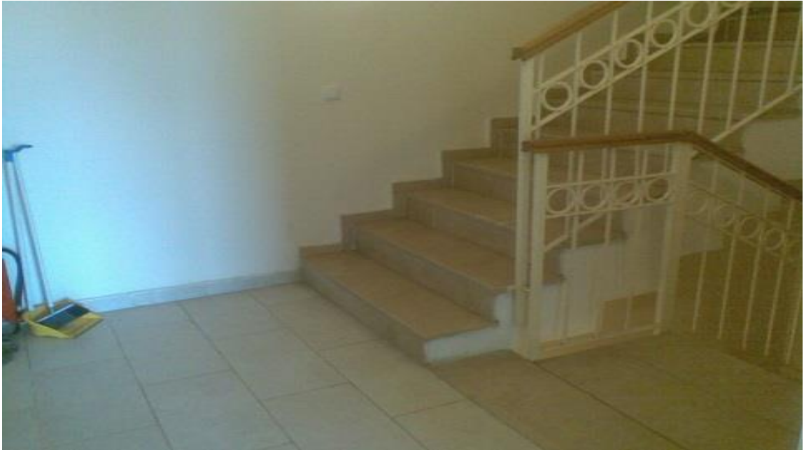
Şekil 4.19:Hacıahmet Semt Konağı İç Merdivenleri
