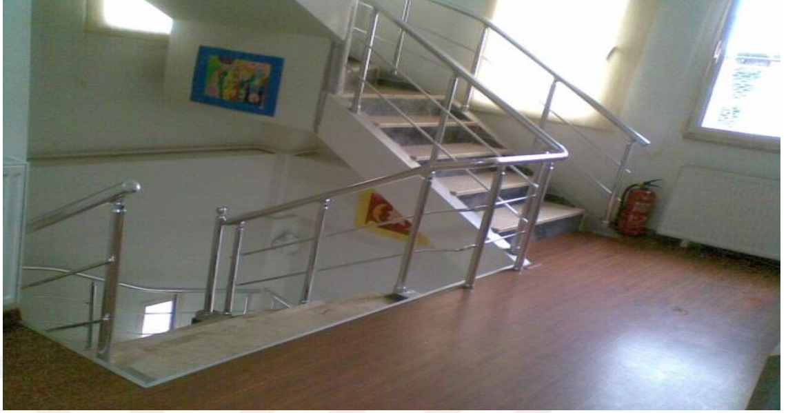
Şekil 4.10:Okmeydanı Semt Konağı İç Merdivenleri
