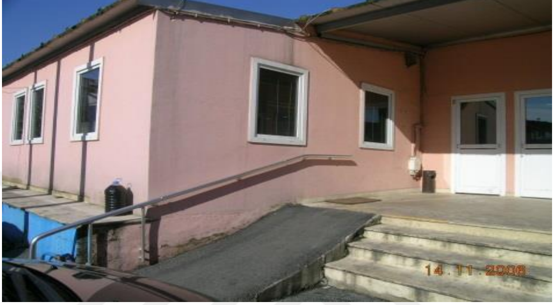
Şekil 4.21: Kasımpaşa Zabıta Müdürlüğü
