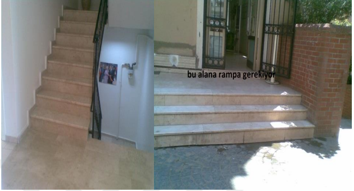
Şekil 4.16:Dolapdere Semt Konağı Giriş ve Bina İçi Merdivenler
