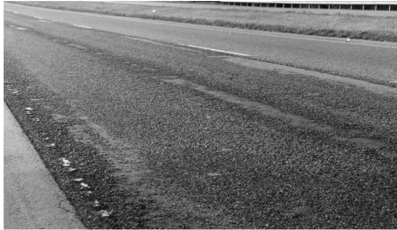
Şekil 2.16: Sökülme ve aşınma örneği
