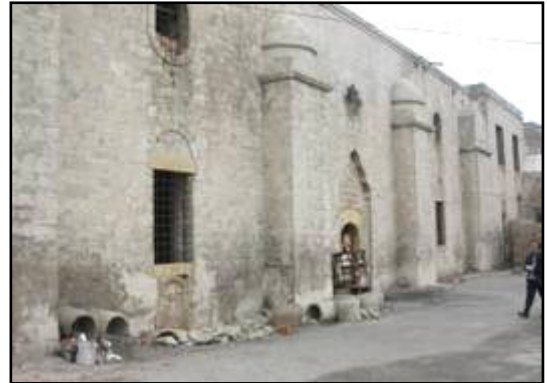
Fotoğraf 3.55 Kilisenin Güney Cephesi
