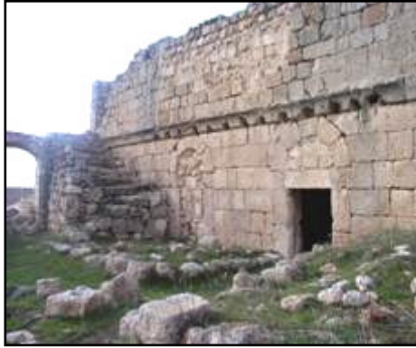
Fotoğraf 3.242 Kilisenin Güney Cephesi
