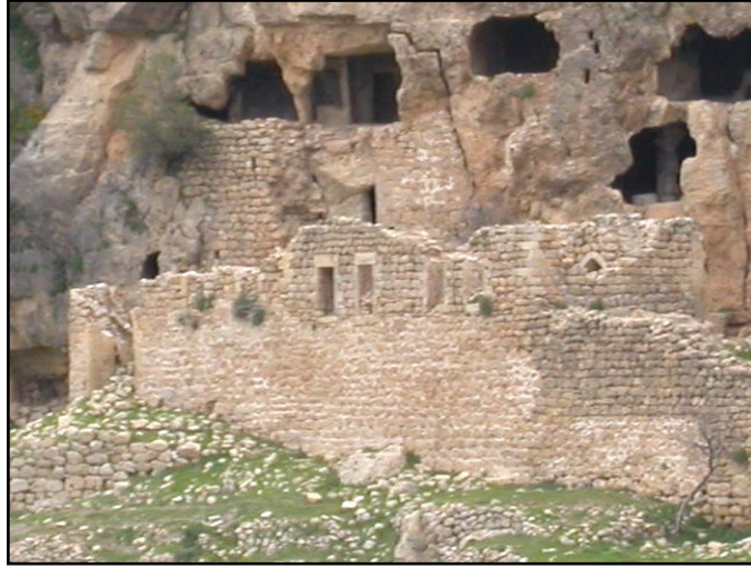
Fotoğraf 3.73 Avlu Önündeki Duvar
