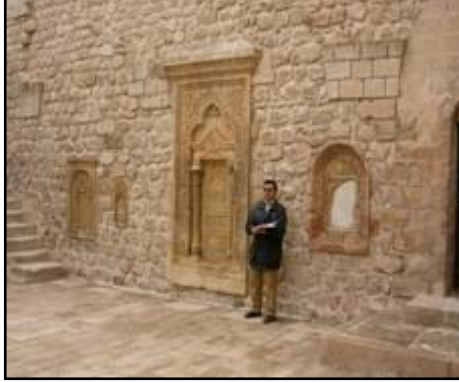
Fotoğraf 3.25 İç Avlunun Batı Cephesi
