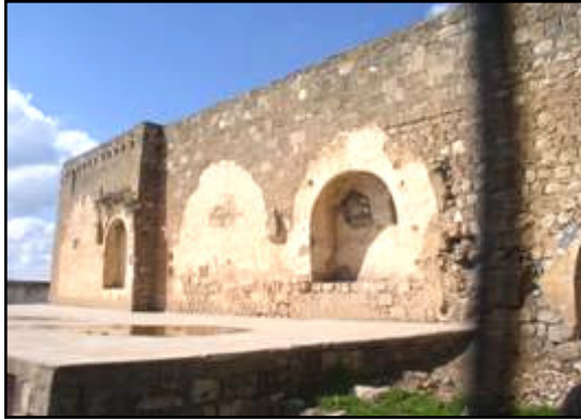
Fotoğraf 3.345 Kilisenin Güney Cephesi
