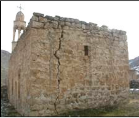
Fotoğraf 3.101 Doğu Cephesi
