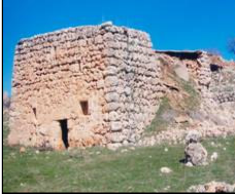
Fotoğraf 3.279 Yapının Güneybatıdan Görünümü
