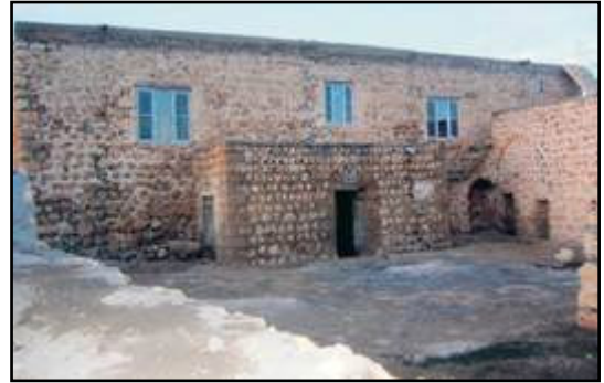
Fotoğraf 3.290 Kilisenin Güney Cephesi
