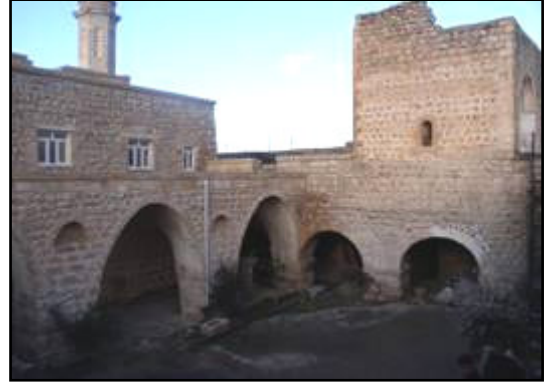
Fotoğraf 3.228 Avlunun Kuzey ve Doğu Cephesi
