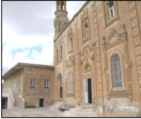
Fotoğraf 3.165 Mort Şarbel Kilisesinin Güneydoğudan Görünümü
