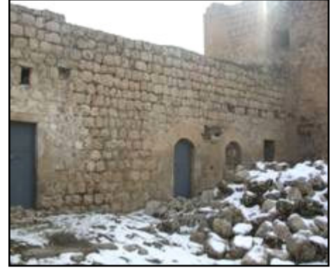
Fotoğraf 3.107 Süryani Katolik Kilisenin Güney Duvarı
