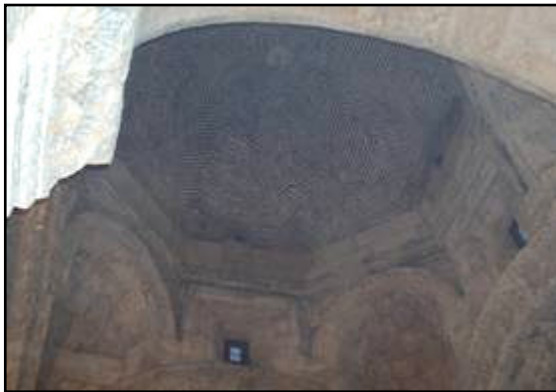
Fotoğraf 3.185 Kilisenin Kubbesi ve Kubbe Geçişleri
