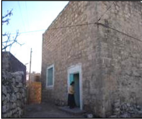
Fotoğraf 3.63 Doğu Cephesi
