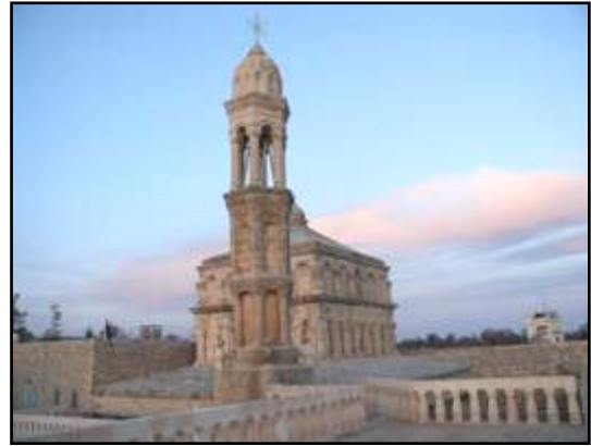
Fotoğraf 3.187 Kilisenin Çatısı ve Çan Kulesi
