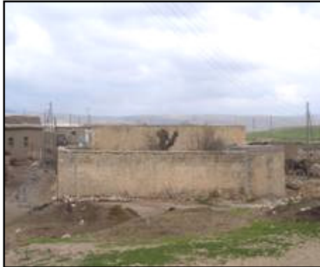
Fotoğraf 3.272 Mor Eşoyo Kilisesinin Güneyden Görünümü
