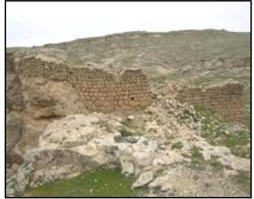
Fotoğraf 3.87 Kilise Kalıntılarının Doğudan Görünümü
