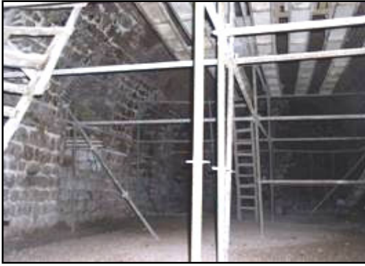
Fotoğraf 3.130 Onarımda Olan Mutfak Bölümü
