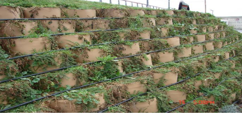
Şekil 2.6. Damla sulama yöntemi (URL 6)
