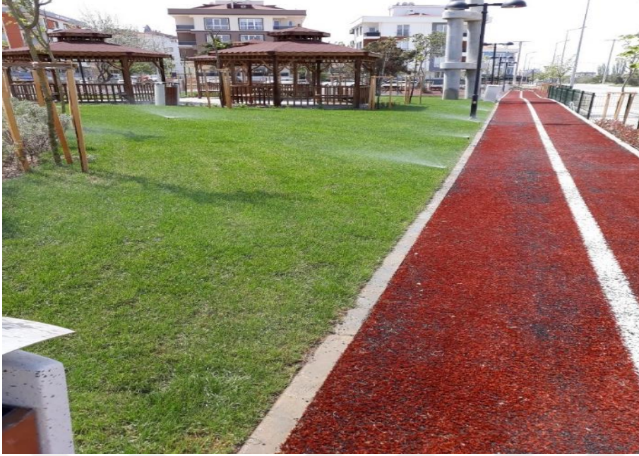
Şekil 4.73. Şehit Emre Bağcı Parkı sprey yağmurlama başlıkları
