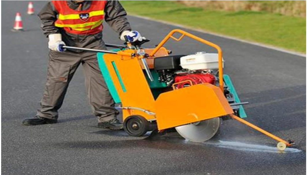
Şekil 4.6: Asfalt kesilmesi
