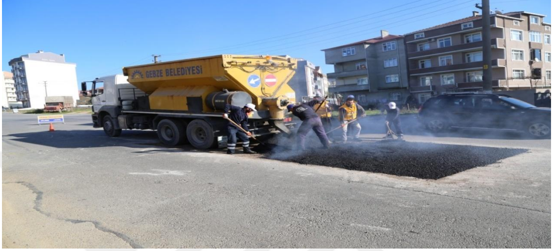
Şekil 4.5: Asfalt Robotu ile bir yama çalışması
