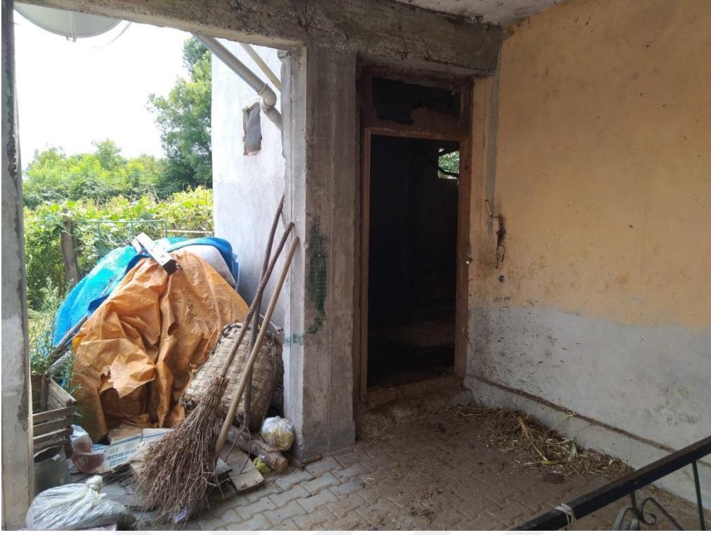
Şekil 4.10. Zonguldak Çaycuma Serdaroğlu Köyü'nde risk değerlendirmesi yapılan ahırın girişi
