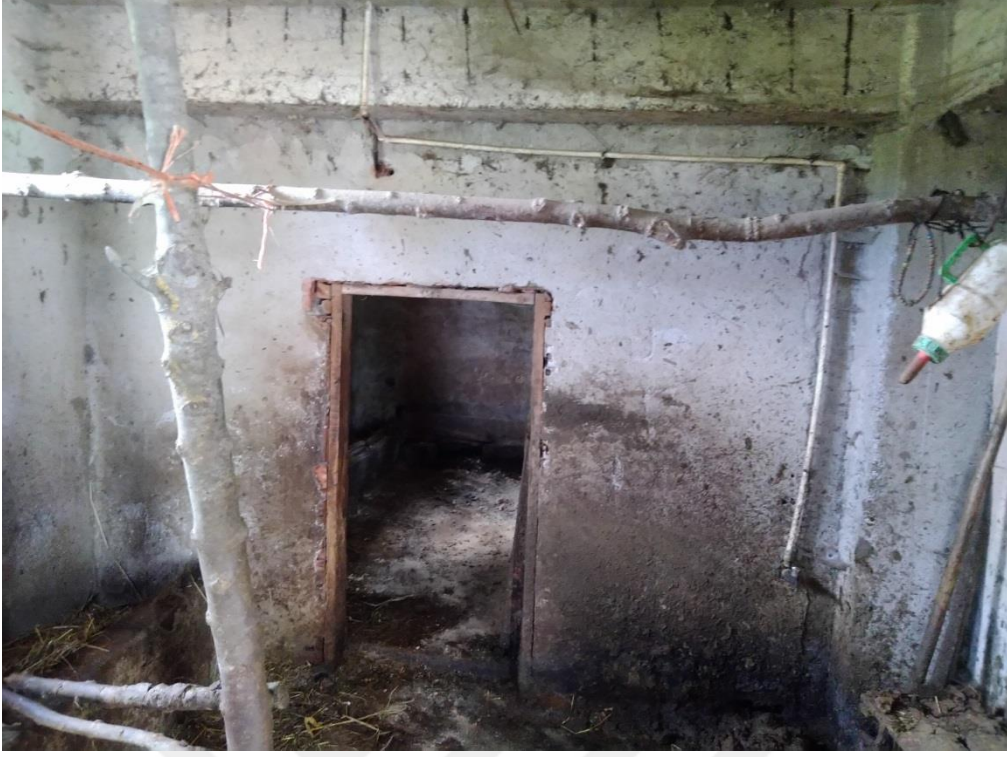
Şekil 4.12. Zonguldak Çaycuma Serdaroğlu Köyü'nde risk değerlendirmesi yapılan ahırın içindeki ikinci odanın girişi (kapı yüksekliği, su musluğu)
