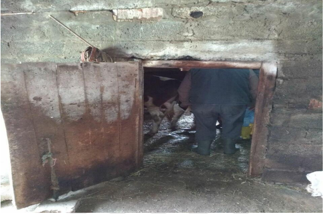
Şekil 4.4. Zonguldak Merkez Himmetođlu K y 'nde bulunan bir ahıra ait kapı
