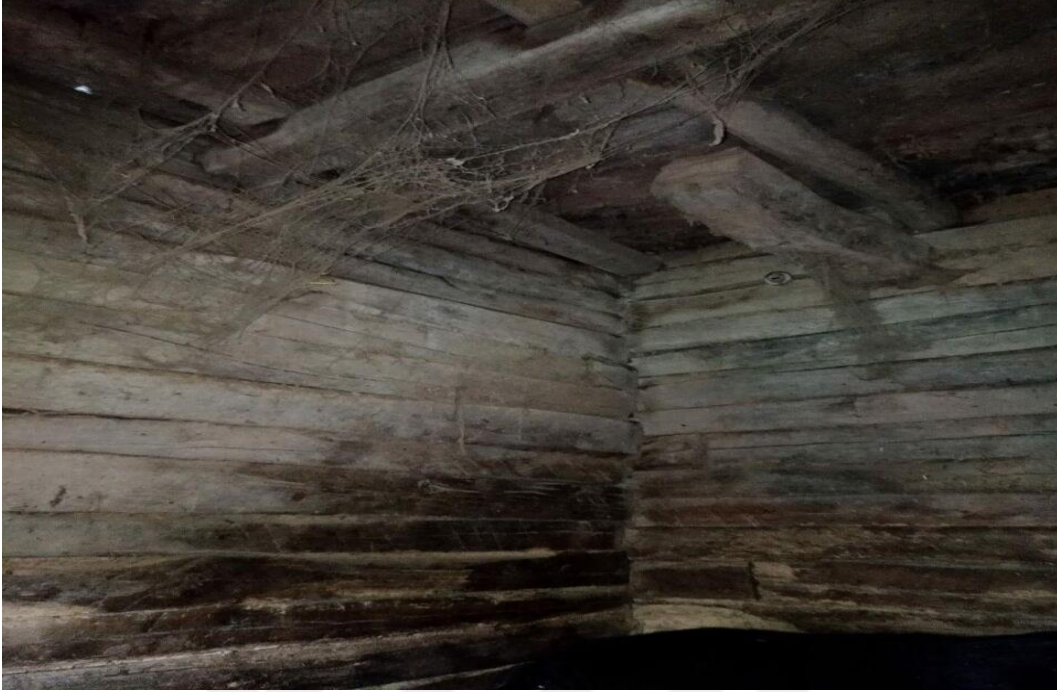
Şekil 4.3. Zonguldak Alaplı Çatak Köyü'nde bulunan bir ahıra ait çatı ve tavan yapısı
