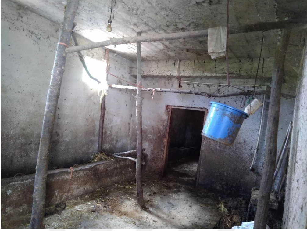
Şekil 4.11. Zonguldak Çaycuma Serdaroğlu Köyü'nde risk değerlendirmesi yapılan ahırın içinin genel görünümü (yemlikler, aydınlatma ve kullanılan ekipmanlar)
