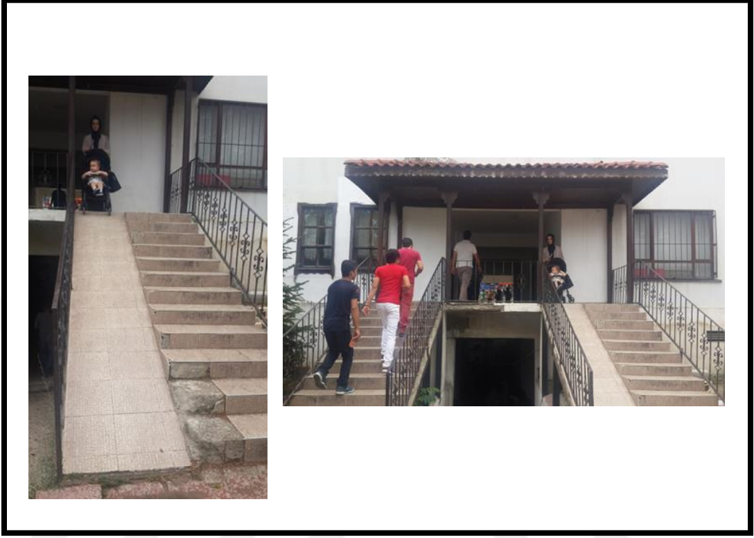
Şekil 4.25: Belediye binasındaki arka geçiş
