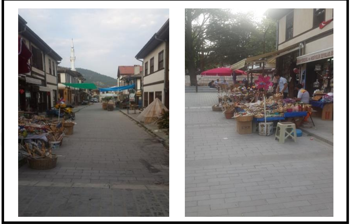
Şekil 4.20: Yunus Paşa Çarşısının mevcut durumu
