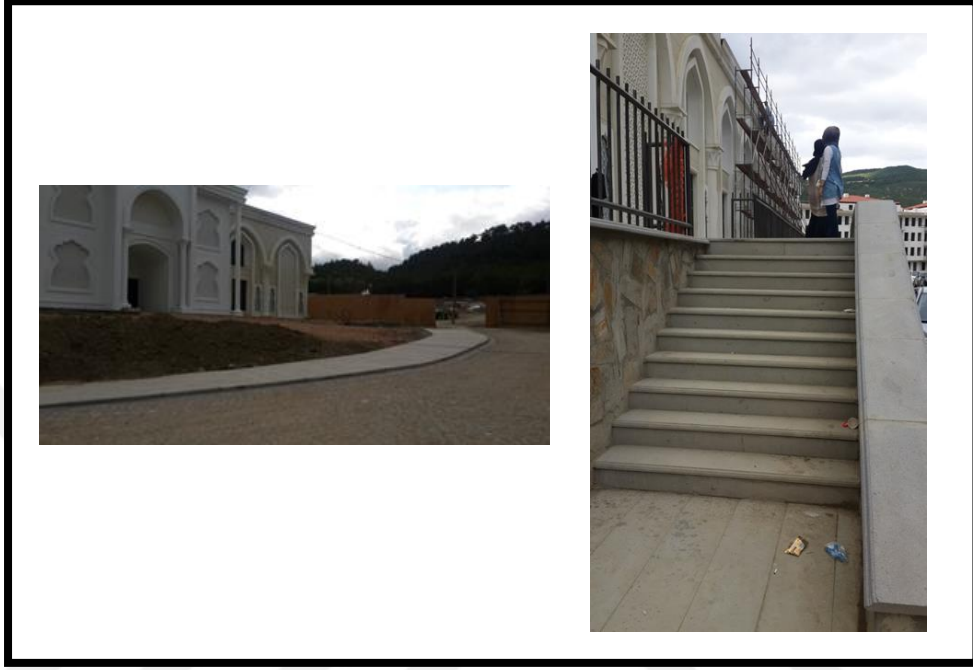
Şekil 4.5: Termal tesis girişleri ve idari bina
