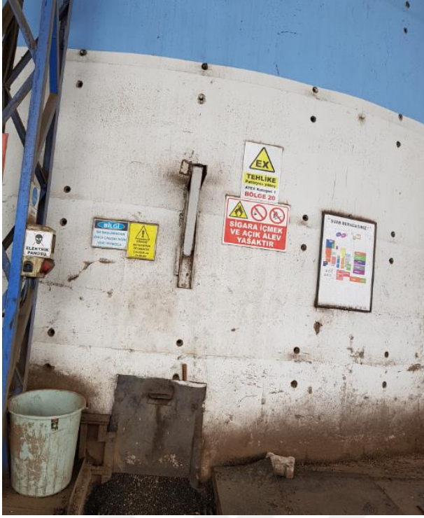
Şekil 4.7. Yağ fabrikasında silonun alt kapak açıkken görüntüsü
