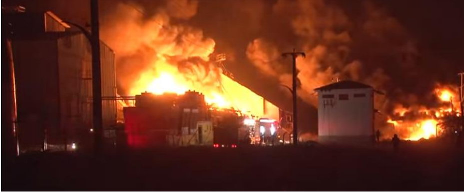
Şekil 1.15. Afyonkarahisar’da yağ fabrikasında yangın (Sözcü, 2017)
