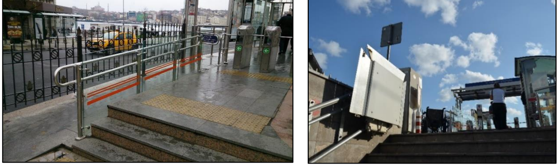
Şekil 5.31: Karaköy tramvay turnike rampası (a) ve platform asansör (b)
