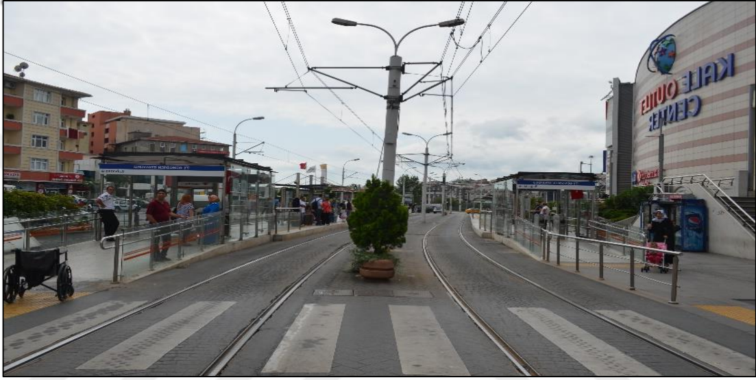
Şekil 3.2: T1 Kabataş-Bağcılar tramvay hattı Güngören istasyonu her iki yönde peron alanı
