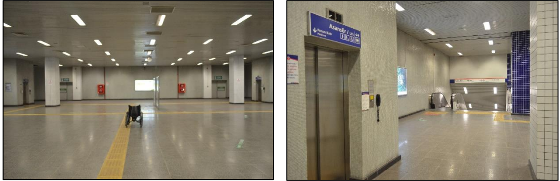
Şekil 5.53: Bahçelievler istasyonu peron alanına geçiş asansörleri
