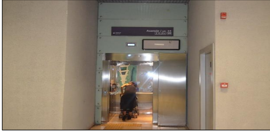
Şekil 5.42: Bağcılar Meydan istasyonu peron asansörü
