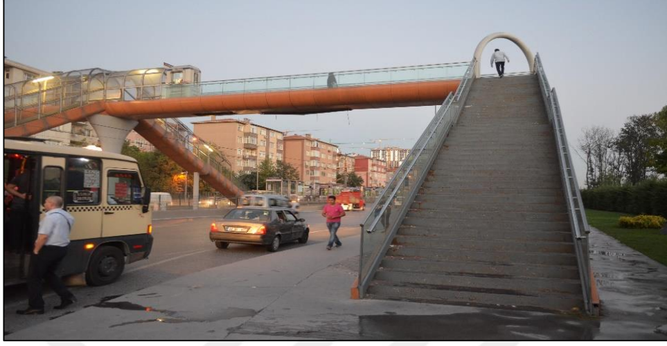
Şekil 3.3: T4 Habibler-Topkapı tramvay hattı Cumhuriyet Mahallesi durağında bulunan üst geçit
