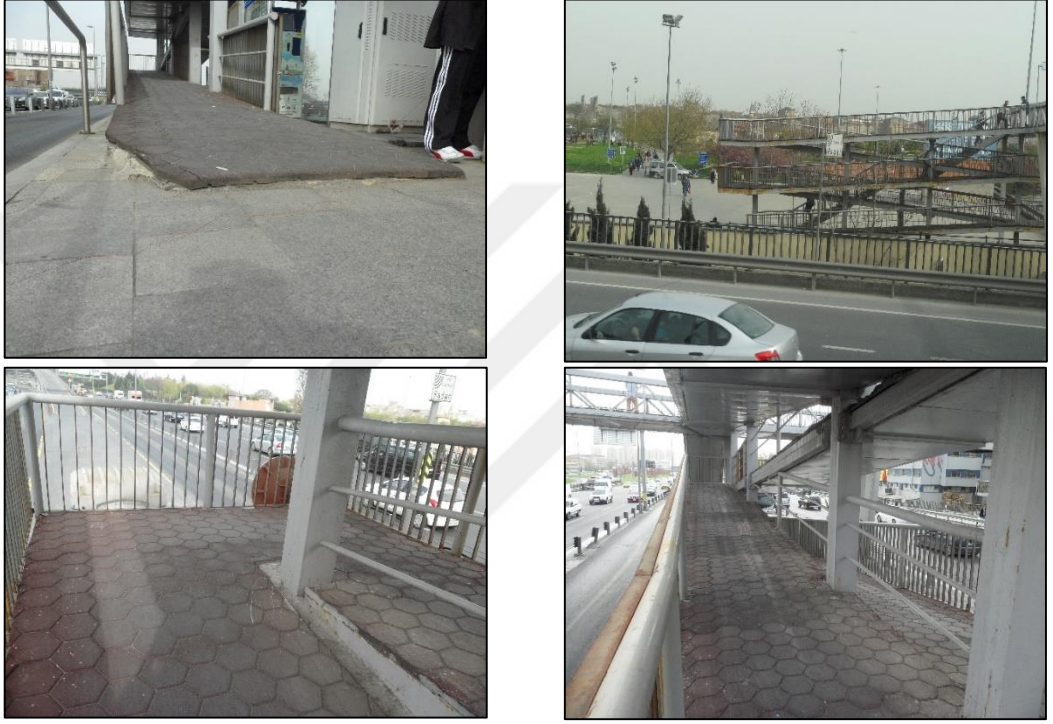
Şekil 5.90: Metrobüse geçişi sağlayan rampalı üst geçit
