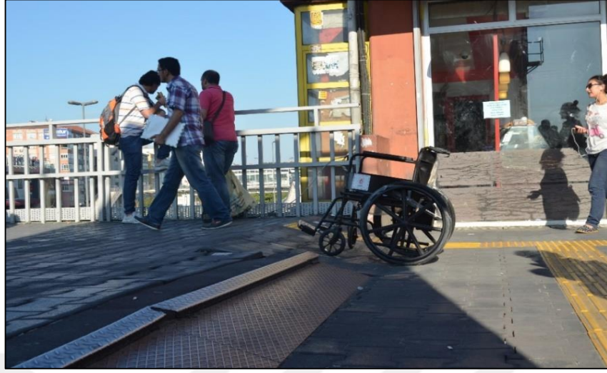
Şekil 5.48: Üst geçitte rampa engeli
