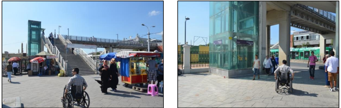
Şekil 5.92: Çırpıcı Şehir Parkı tarafından asansör ile geçiş
