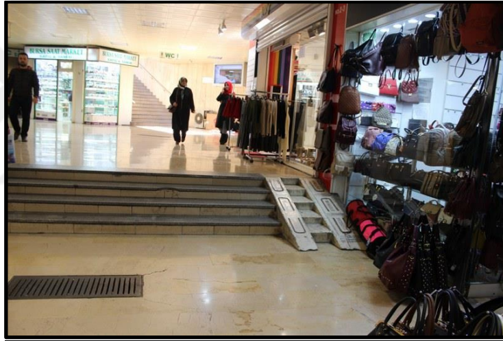
Şekil 6.24: Yanlış rampa uygulamaları kaynaklı problem örneği
