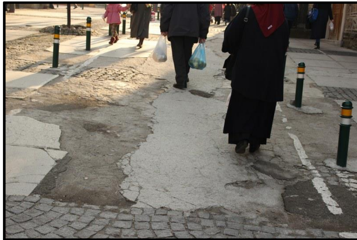
Şekil 6.10: Zemin malzemesi tahribatı kaynaklı problem örneği
