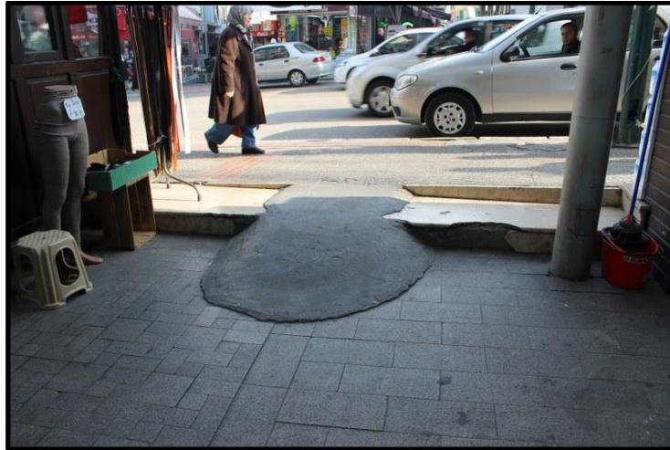
Şekil 6.24: Yanlış rampa uygulamaları kaynaklı problem örneği
