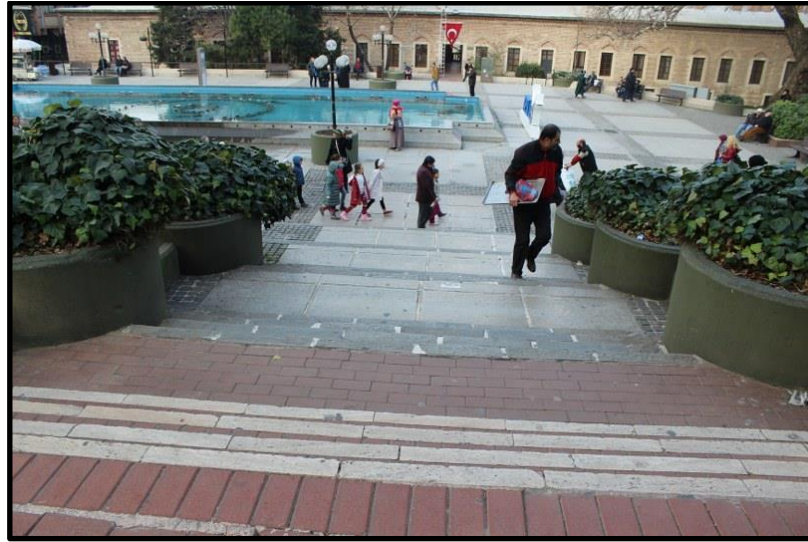
Şekil 6.13: Rampa eksikliği kaynaklı problem örneği
