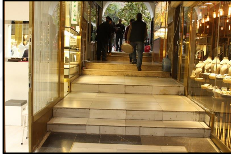
Şekil 6.16: Rampa eksikliği kaynaklı problem örneği
