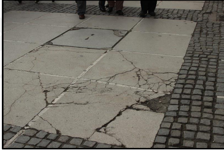
Şekil 6.7: Zemin malzemesi tahribatı kaynaklı problem örneği
