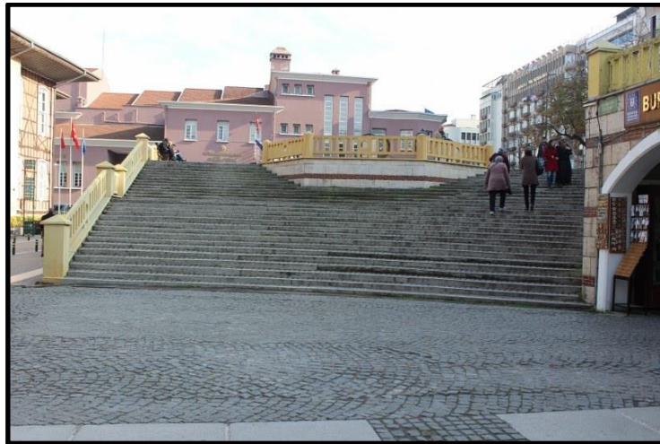
Şekil 6.19: Rampa eksikliği kaynaklı problem örneği
