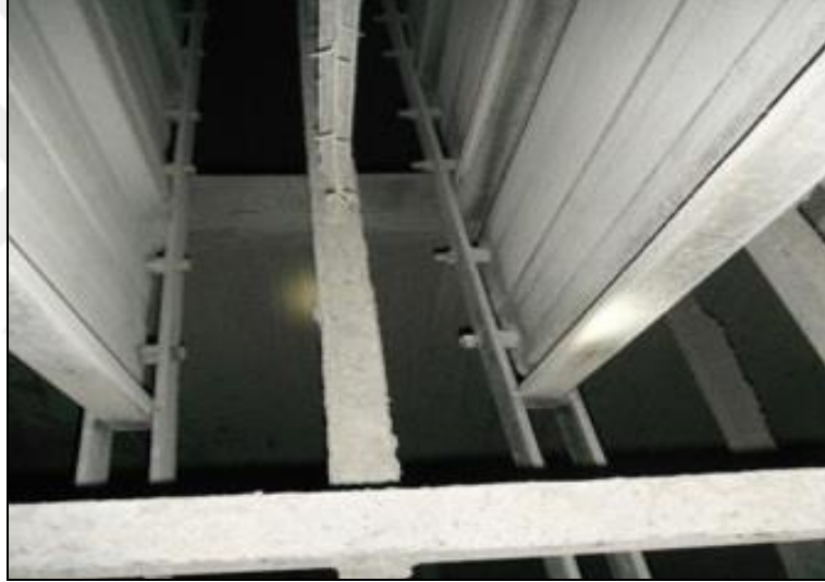
Şekil 3.4: Toplama elektrodu sabitleme sistemi
