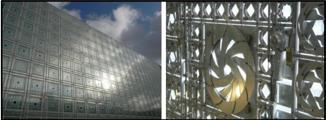
Figure 2.15: Institute Monde du arabe, Jean Nouvelle, 1987
