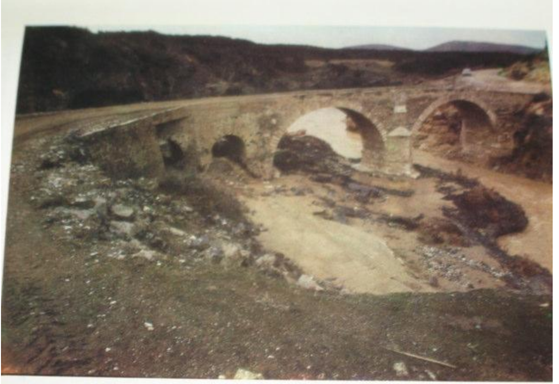
Fot. 13 — Hoca Seyfeddin Köprüsü
