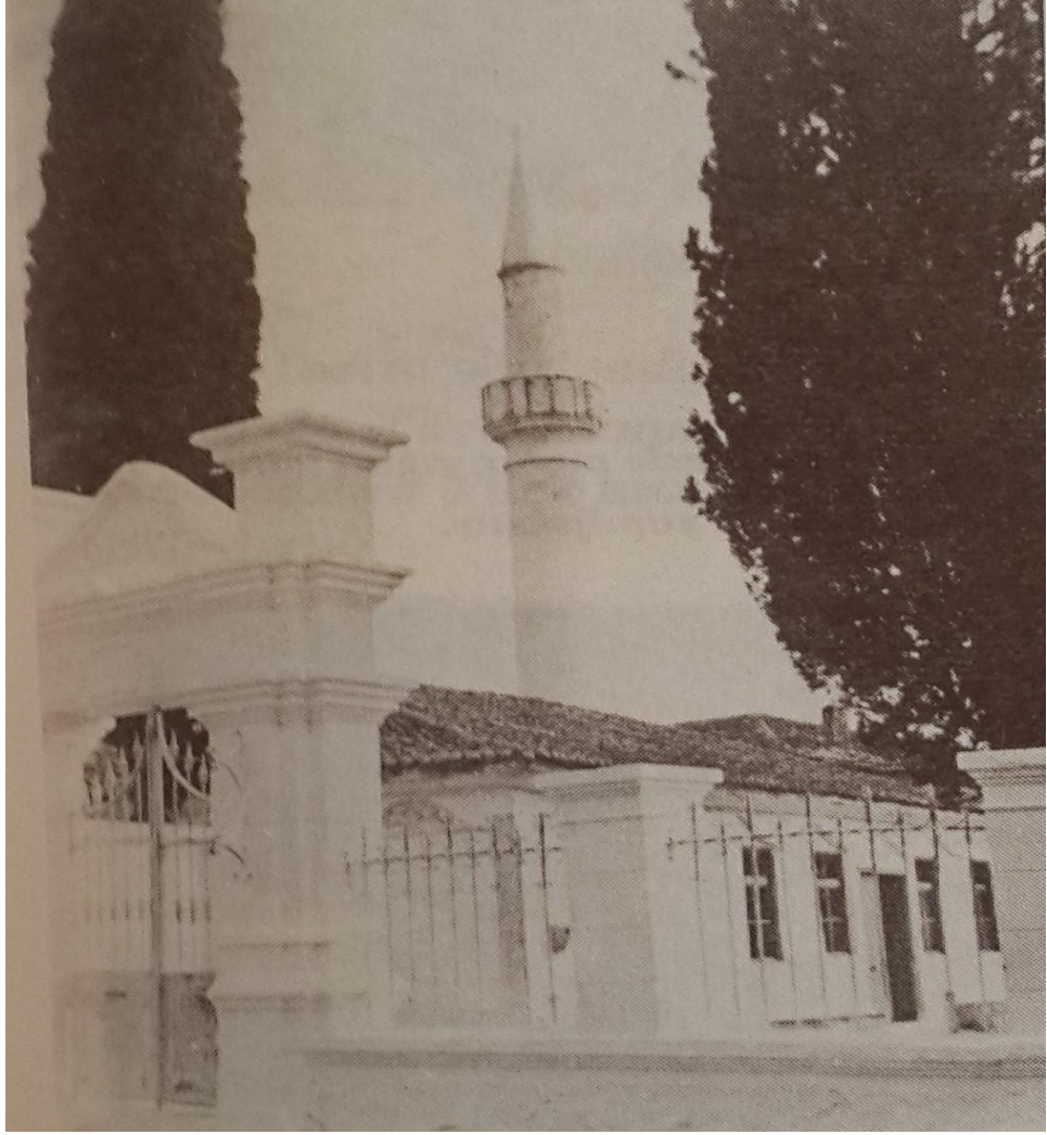
Resim 14- Tabakhane Camii’nin yıkımdan önceki son fotoğrafı 746
