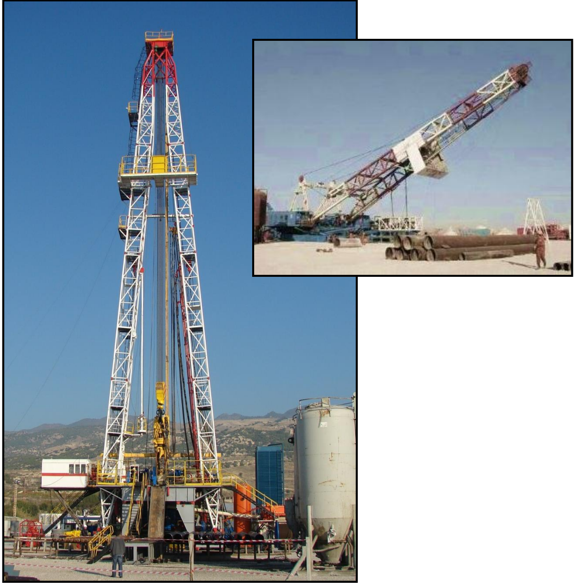
Şekil 4.1: Sondaj kulesi ve kule kaldırma operasyonu
