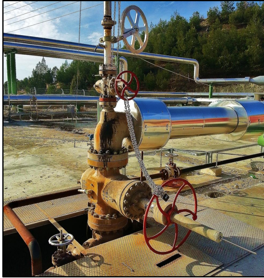
Şekil 4.8: Kuyubaşı vanaları
