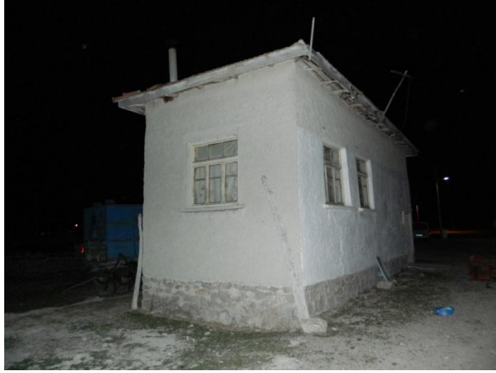
Resim 47: Konya Barana Odasının Dışarıdan Görünümü
