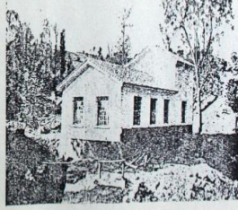
Şehri Aydınlatan Elektrik Santrali
