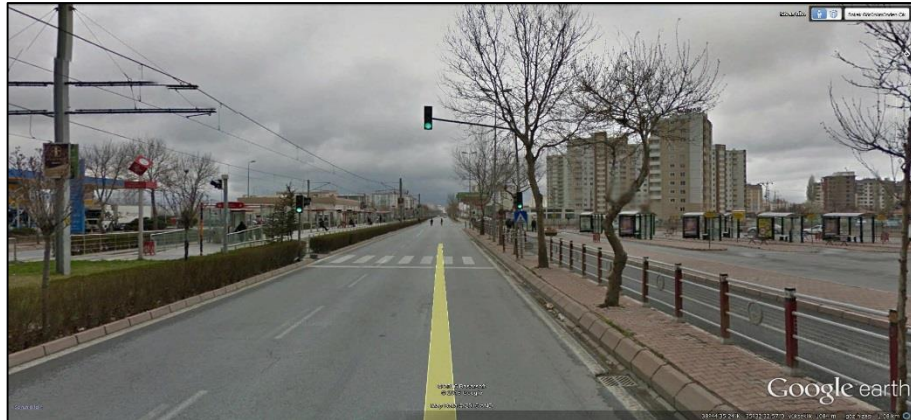
Şekil 4.40: Doğu terminali aktarma istasyonu
